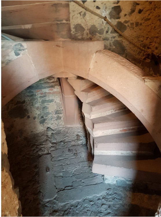
Abbildung 6: Aufbau der barocken Wendeltreppe im Bergfried der Ronneburg (Riemer)
