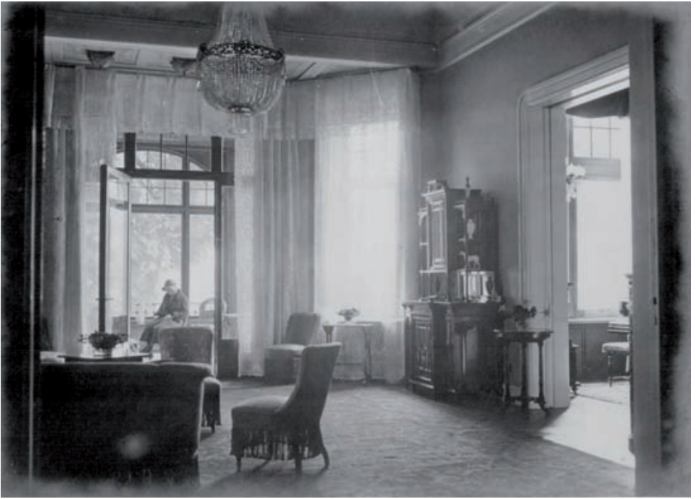
Wohnhaus Harvestehuder Weg, Innenräume
