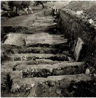
Abb. 14: Halieis, Areal 1 / Bereich 1
