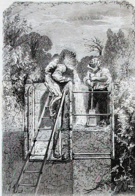
NOUVEAU MODE DE CONSTRUCTION EN BÉTON.
