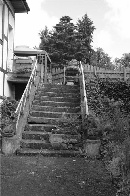
Die mit einem Eisengeländer versehene Treppe überwindet eine Höhe von 2,35 m. Sie besteht aus 12 Granitstufen, die – abgesehen von der untersten mit runden Seitenwangen versehenen – in den Maßen weithin übereinstimmen: B: 1,75 m; H: 0,15–20 m; T: 0,30–40 m (oberes Podest: 1,25 m)
