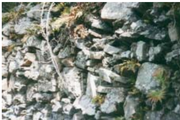
Fig. 35 La disposizione delle pietre a secco. Particolare di un muretto.
