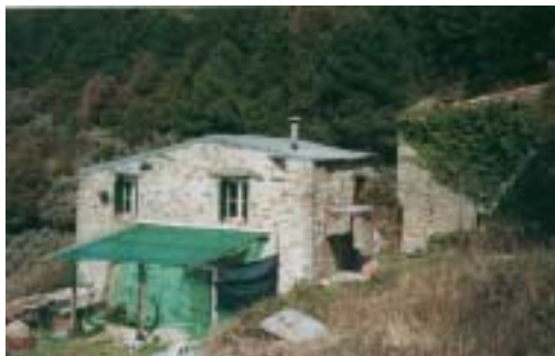
Fig. 9 Lemmen. Particolare di una casa restaurata di recente da privati.
