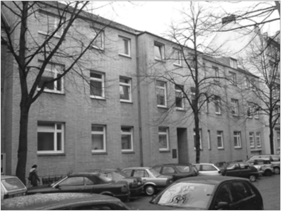
Abbildung 19 b: 1961 wurde die Verklinkerung mit gelbem Backstein ausgeführt.
