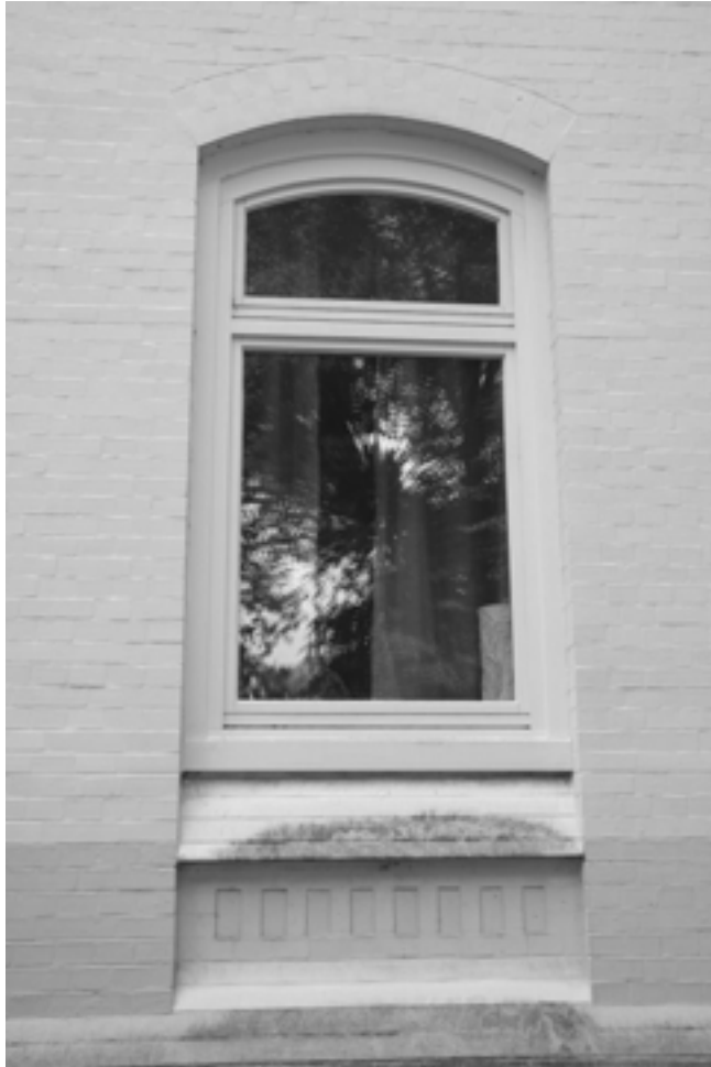
Abbildung 18: Die Verzierungen der Fenster bestehen alle aus Backstein. Ein gemauerter unauffälliger Korbboogen hebt die Rahmen von der restlichen Fassade ab.
