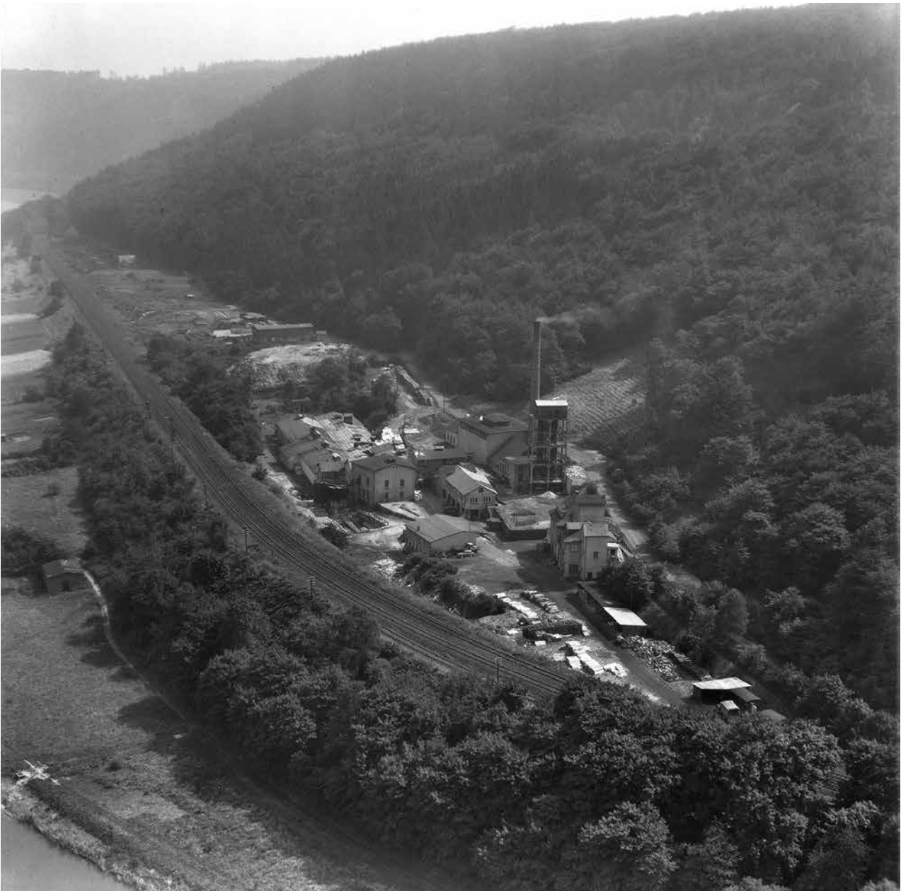
Abb. 20: Luftbild von der auf Alexander Mitscherlich zurückgehenden Mündener Zellulosefabrik, vermutlich 1956 (Quelle: StadtA HM, Industriefotos_Cellulosefabrik_Schulzenrode [1]; Stefan Schäfer, schriftliche Mitteilung v. 11. März 2022).
