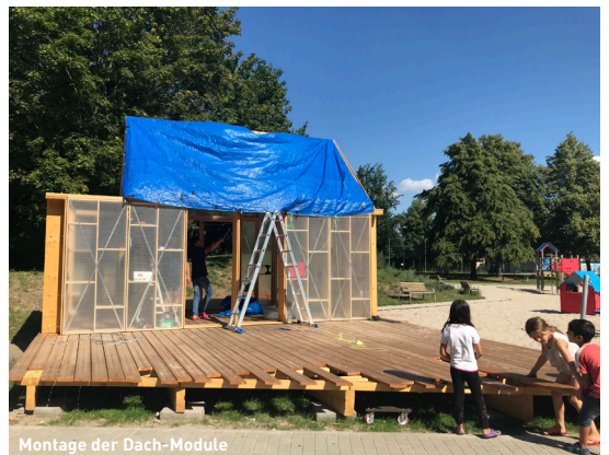
Montage der Dach-Module
