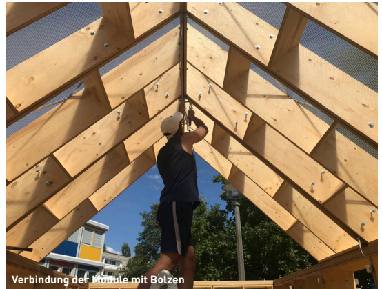
Verbindung der Module mit Bolzen
