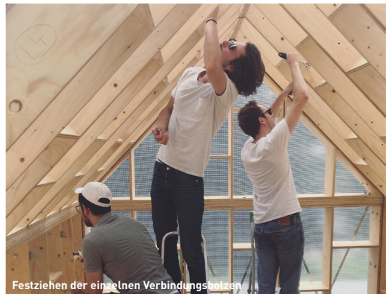
Festziehen der einzelnen Verbindungsstellen
