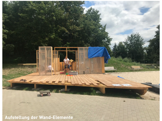
Aufstellung der Wand-Elemente
