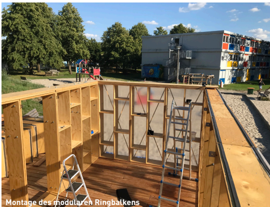
Montage des modularen Ringbalkens
