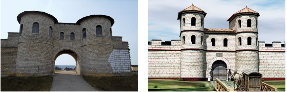
Abb. 5 Nordtor des römischen Kastells Biriciana, Weißenburg i. Bay. Nach aktuellem Forschungsstand ist dieser Nachbau aus den 1980er Jahren (links) um mindestens ein Stockwerk zu niedrig. Rechts: virtuelle Idealrekonstruktion des Tors, 2013. Foto: Christof Flügel, Grafik: ArcTron 3D/Museen der Stadt Weißenburg/Landesstelle für die nichtstaatlichen Museen in Bayern
