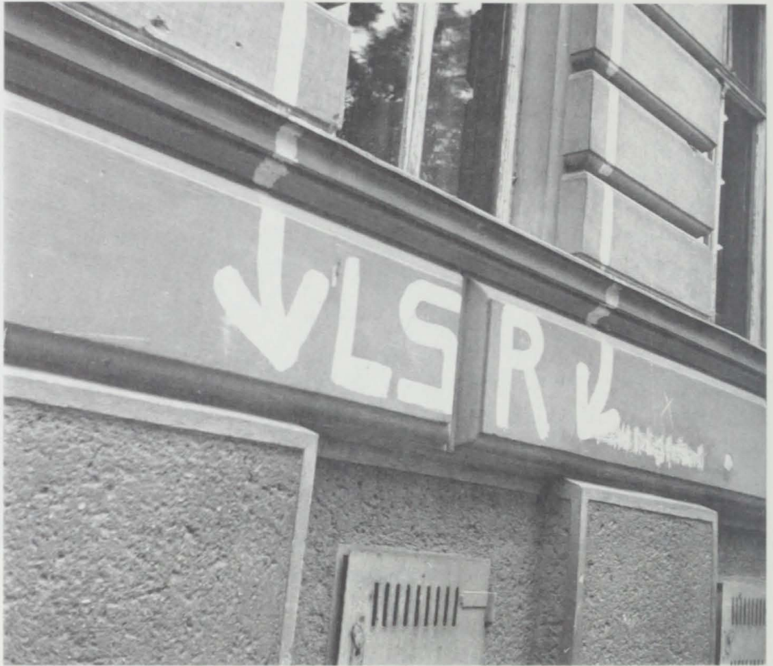
Abb. 117: Haus mit Aufschrift LSR (Luftschutzraum)
