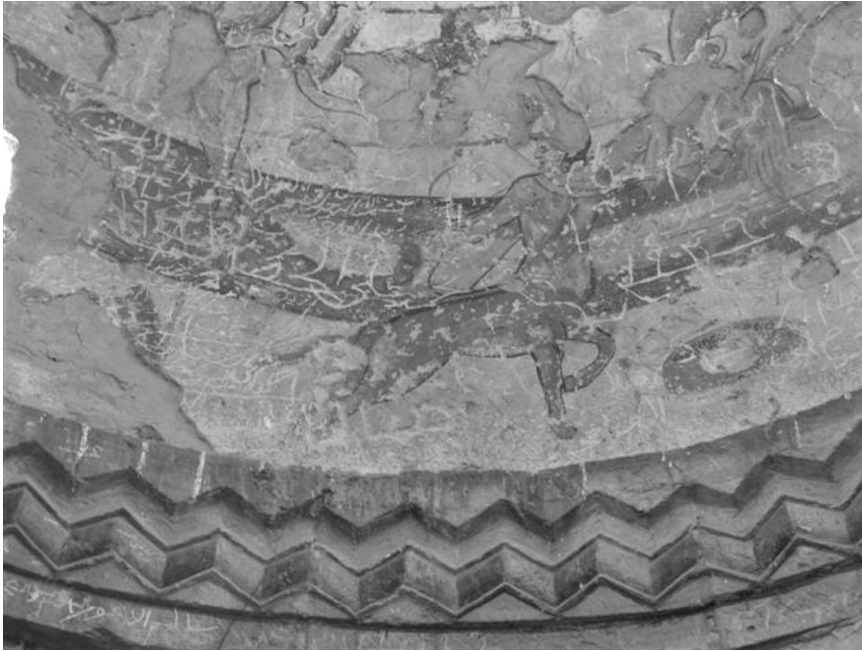
Abb. 23: Azraq (Jordanien), Quşayr 'Amra, 723–743, Gewölbe im Caldarium
