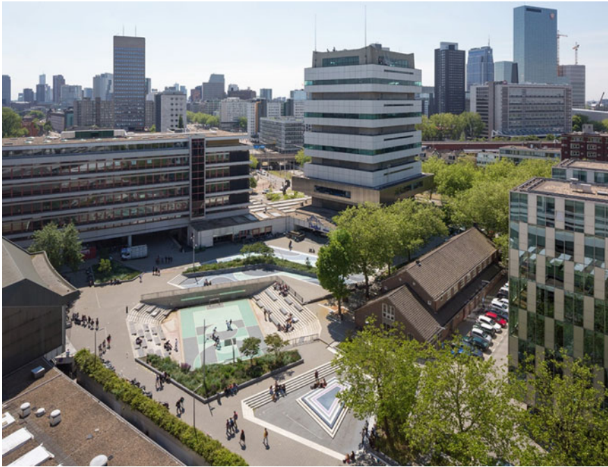
Fig. 59.3 Bentemplein, Rotterdam, 2013, De Urbanisten, Ph. Ossip van Duivenbode
