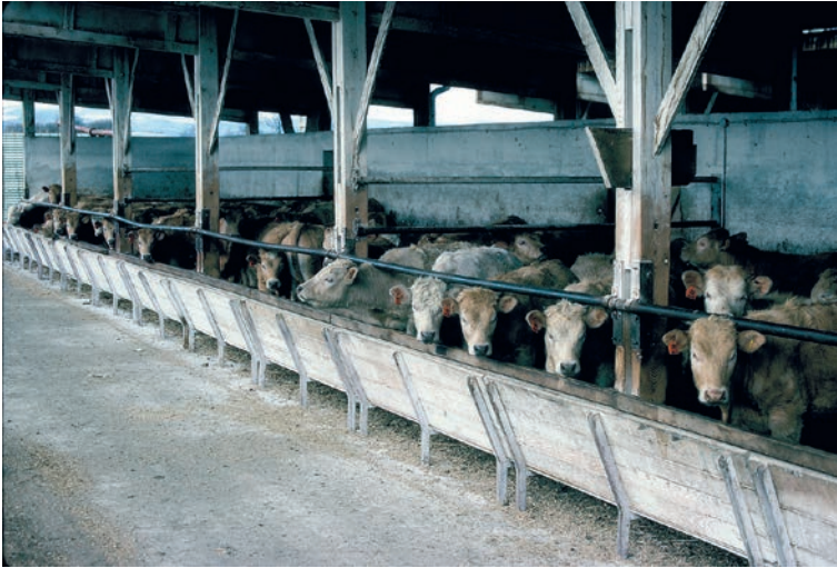
À Montrond-les-Bains, bâtiment d'élevage du début des années 1970 dédié aux veaux destinés à être « finis » en taurillons. © Institut de l'élevage.
