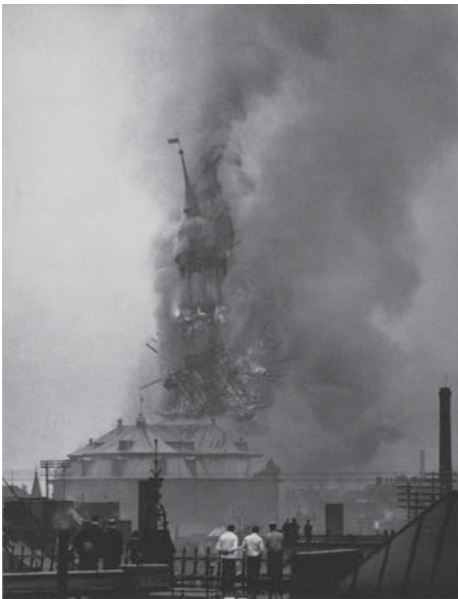
Einsturz des Turms der Kirche St. Michaelis (1906)
