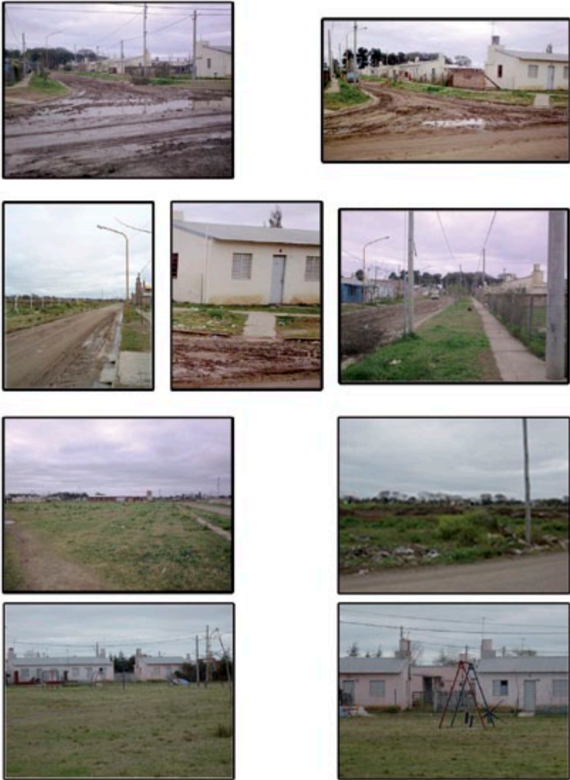
Figura 6: Nessuna delle strade interne è asfaltata e non ci sono canalette per lo scolo dell'acqua, con le conseguenti pericolosità e, a volte, impraticabili. L'illuminazione pubblica nelle strade è inadeguata e, ove presente, è alimentata da lampioni al sodio che non garantiscono adeguata illuminazione notturna. I marciapiedi, stretti ed in genere realizzati in lastre di cemento, hanno rampe di accesso alle abitazioni inefficaci a causa delle pessime condizioni delle strade.
