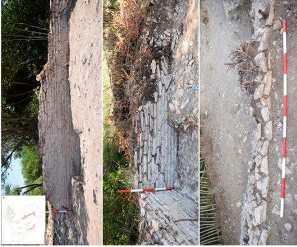
Figura 16. Obra de opus testaceum correspondiente a la nueva infraestructura que ocupó la cabeza del muelle durante esta fase.
