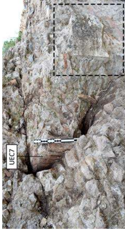
Figura 11. Sistema de arco de descarga documentado en la esquina nororiental.
