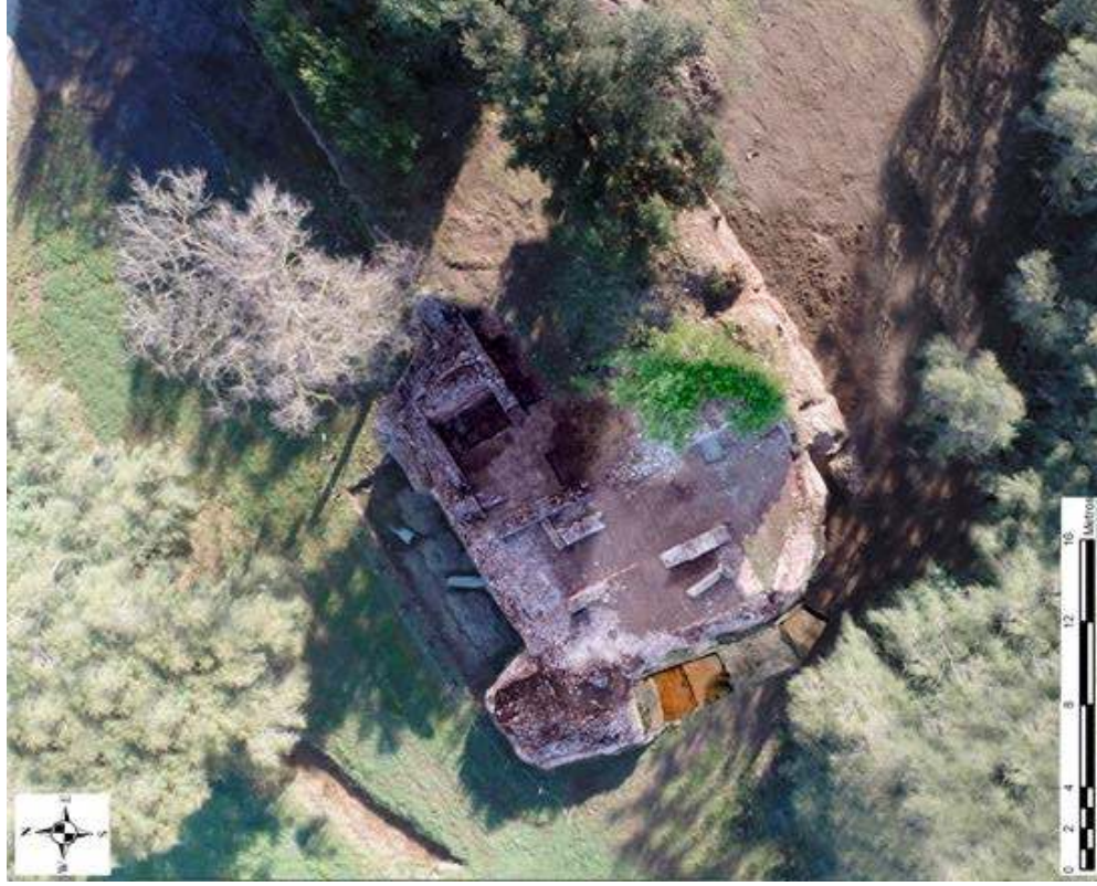
Figura 18. Vista aérea del extremo del muelle con indicación de la ubicación del Sondéo.
