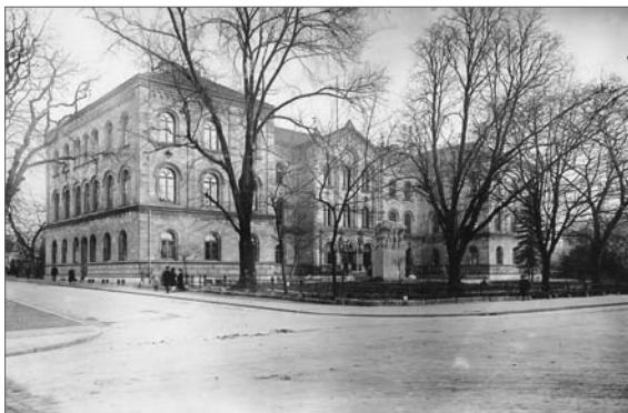
■ Weender Landstraße 2, Auditorium
