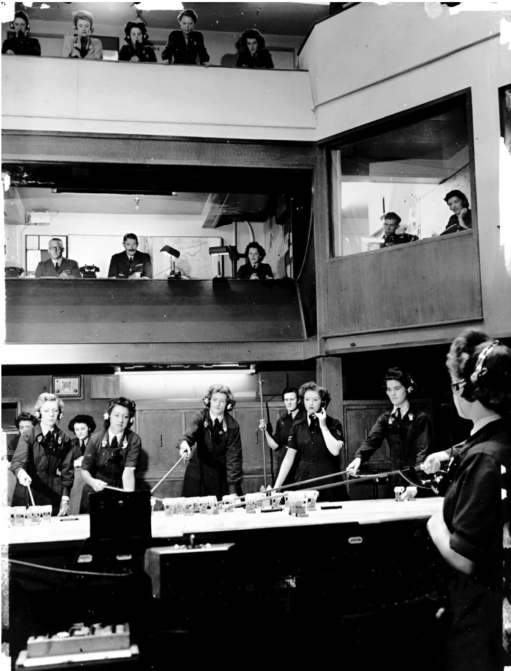
Abbildung 36: Historischer Blick in den Operations Room der 10. RAF Fighter Group.
