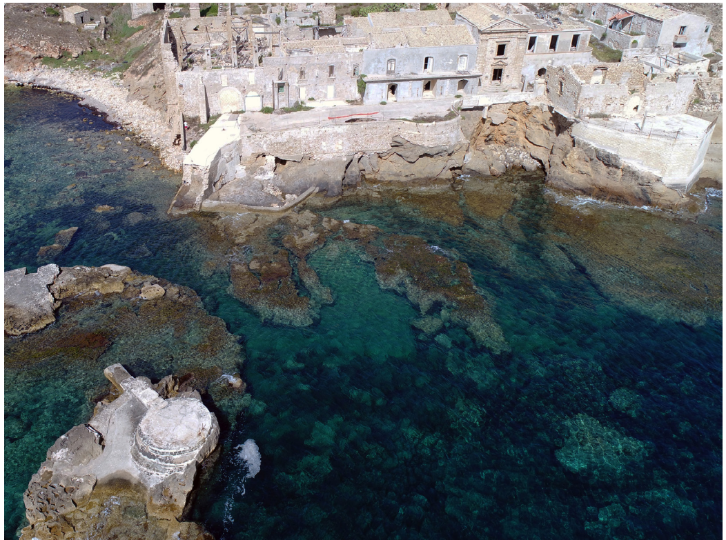
Fig. 4. Tonnara di Capo Passero ripresa da drone.
