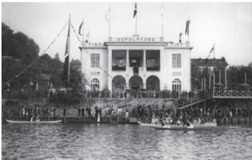
Figure 6.2 The Dopolavoro built by FIAT, Corso Moncalieri, 1929. (Italian Archivio e Centro Storico Fiat).
