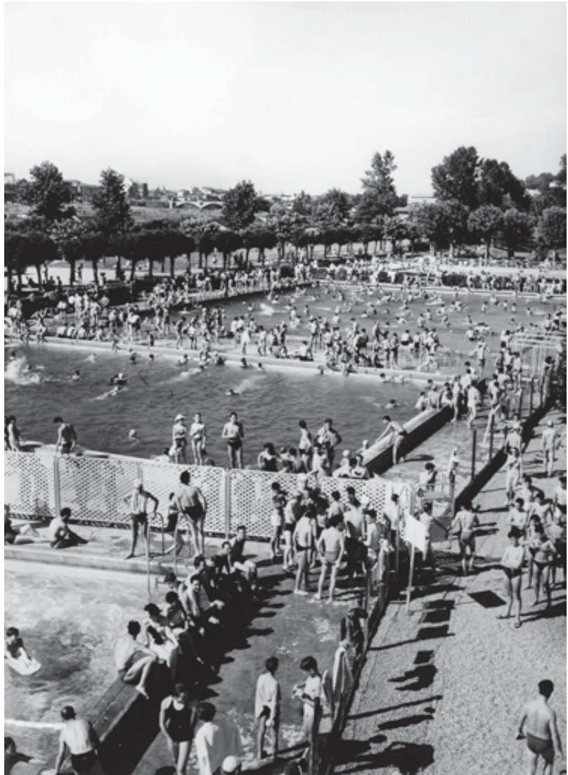
Figure 6.4 The FIAT swimming pool centre, Corso Moncalieri. (Italian Archivio e Centro Storico Fiat).
