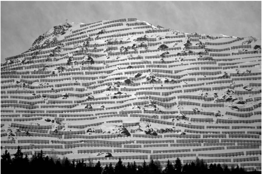
Abbildung 1: Lawinenverbau, St. Anton
