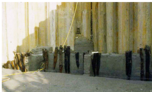
Figura 38. Pisa. Palizzata di fondazione in legno (da Camilli 2004).
