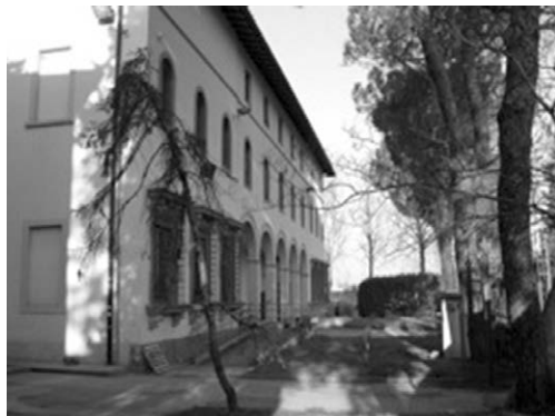
Fig. 28 – Veduta del complesso didattico di Quaracchi
