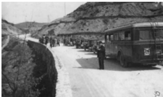
Fig. 25 – Sistemazioni di versante nella zona di Rufina
