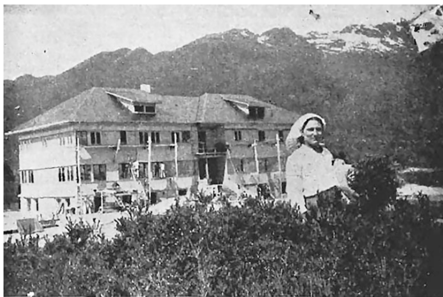
Otro aspecto del hotel en construcción
