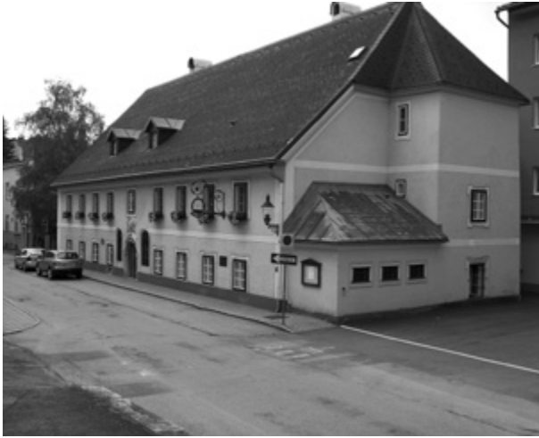
Abb. 35: Mariazell; Unterer Spital (Wiener Straße 35). Das in der ersten Hälfte des 18. Jahrhunderts errichtete, zweigeschossige Spital (neun Achsen mit Schopfwalmdach) wurde im frühen 17. Jahrhundert gegründet, seit 1789 k. k. Religionsfonds der Herrschaft Mariazell, seit 1967 zum „Heimatmuseum“ umgewidmet. Neben dem Eingang befinden sich in Nischen links und rechts vom Tor barocke Heiligenfiguren wie die Pest- und Frauen-Heiligen Anna, Sebastian und Rochus (Foto: Martin Scheutz, 2013).
