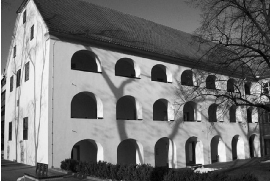
Abb. 23: Graz; Armenhaus (1728 gegründet, 1754 Belegung mit über 600 Personen) in der Albert-Schweizer-gasse 34–38, Graz V. (heute Verwaltungsgebäude der Geriatriischen Gesundheitszentren der Stadt Graz bzw. auch Wohntrakt); 1928 von der Stadt Graz baulich erweitert und als städtisches Spital und Altersheim weitergeführt, Kriegsschäden 1944/45 (Foto: Alfred Stefan Weiß, 2012).
