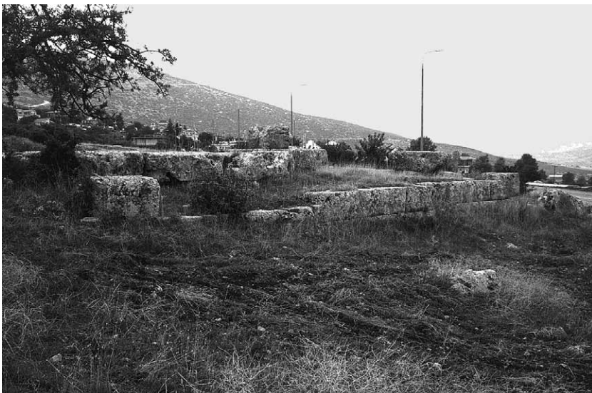
74 Diateichisma, Treppe auf den Wehgang, erhaltener Sockel hinter D 5
