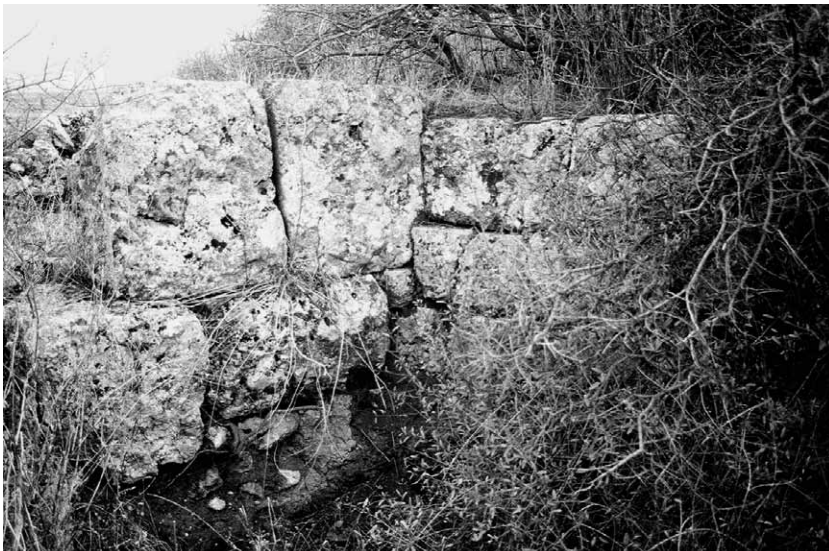
45 Großer Mauerring, R 3, Außenschale des Mauersockels (links) und Mauersockel der nach Osten ablaufen- den Außenschale der Kurtine (rechts)
