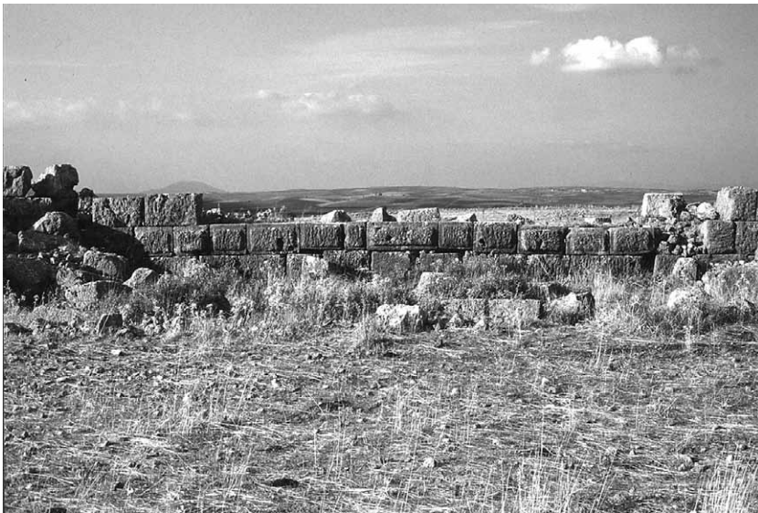
86 Spätantike Befestigung, Kurtine zwischen den Türmen A 3 und A 4, Außenschale
