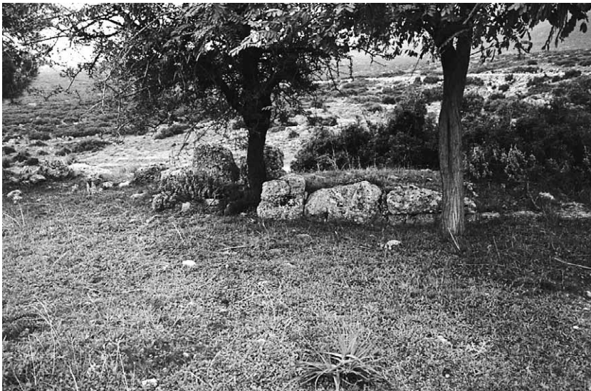
27 Großer Mauerring, Treppe an der Kurtine bei T 11, östliches Ende des Treppensockels. Links im Bild Innenschale der Kurtine
