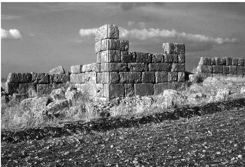
87 Spätantike Befestigung, Turm A 5, Ansicht von Süden
