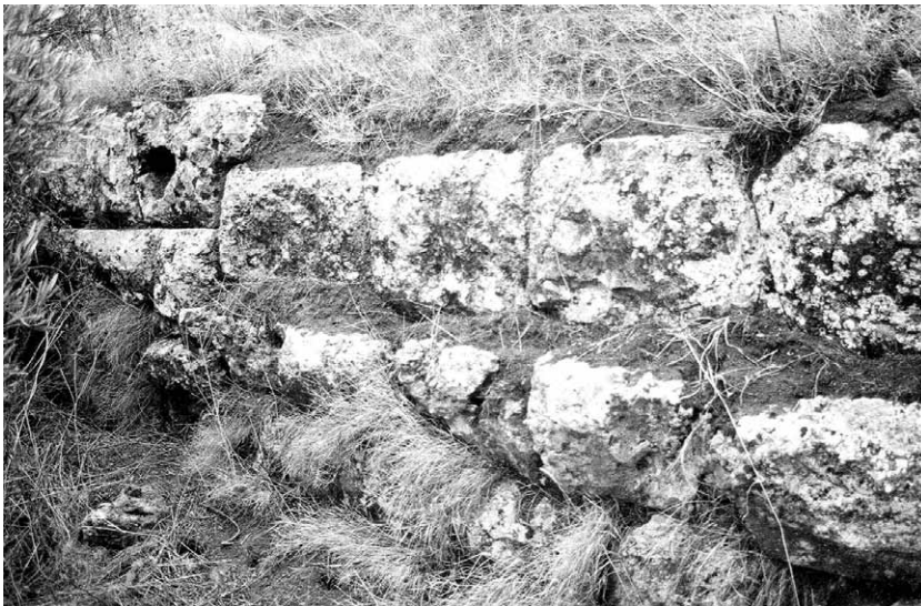
50 Wie Abb. 49, Detail- ansicht des Mau- ersockels auf dem zweischarigen Funda- mentsockel
