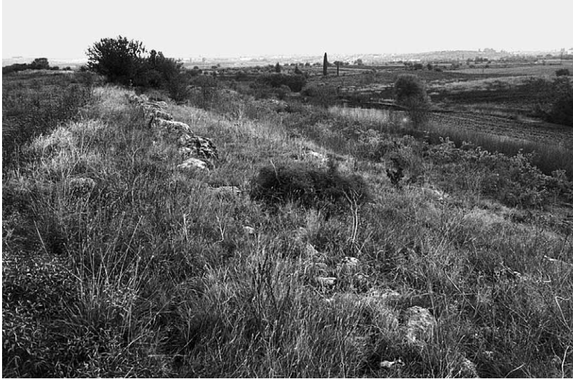
43 Großer Mauerring, Kurtine zwischen T 22 und T 23; links Mauersockel der Innenschale, rechts davon Versturzfeld, Blick nach Norden
