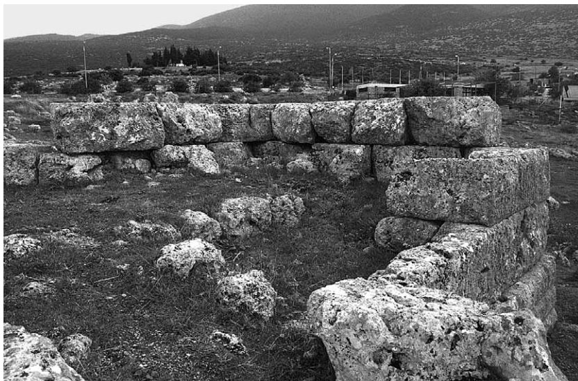
69 Diateichisma, D 3, Blick in den Turm- sockel mit Innenseite der Mauerschalen und Kastenmauer
