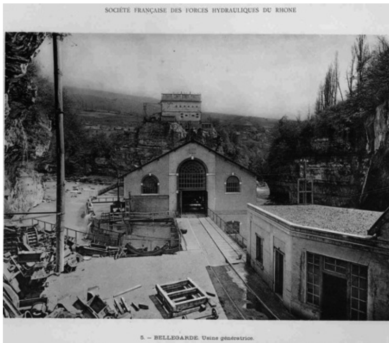
Figure 2 : Usine génératrice à Bellegarde-sur-Valsérine en 1911 19
