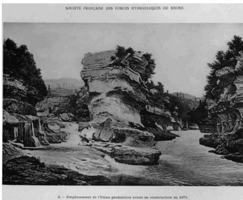
Figure 1 : Vue avant construction de l'aménagement hydraulique du Rhône à Bellegarde-sur-Valserine en 1871 18
