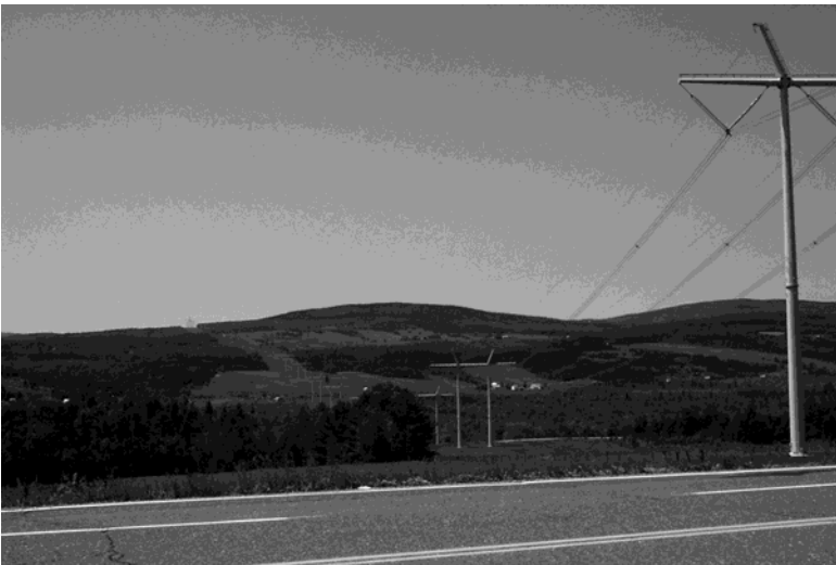
Figure 2 : Implantation de pylônes tubulaires dans la vallée du lac Williams, ligne Des Cantons-Lévis.
