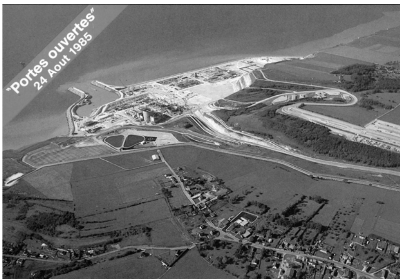
Figure 1 : Vue aérienne de la centrale nucléaire de Penly en construction. Carte postale imprimée et diffusée par EDF à l'occasion de visites du chantier en 1985. © EDF-REC/D. Poidvin
