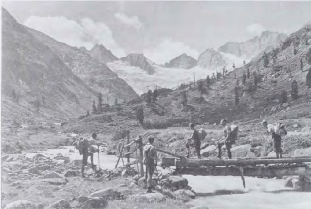
Abb. 97: Auch Brücken legte der DuOeAV im Gebirge an. Diese mussten besonders überlegt angebracht werden, da auch Hochwasserstände in Betracht gezogen werden mussten. Hier die Brücke im Rainbachtal in den Zillertaler Alpen.
