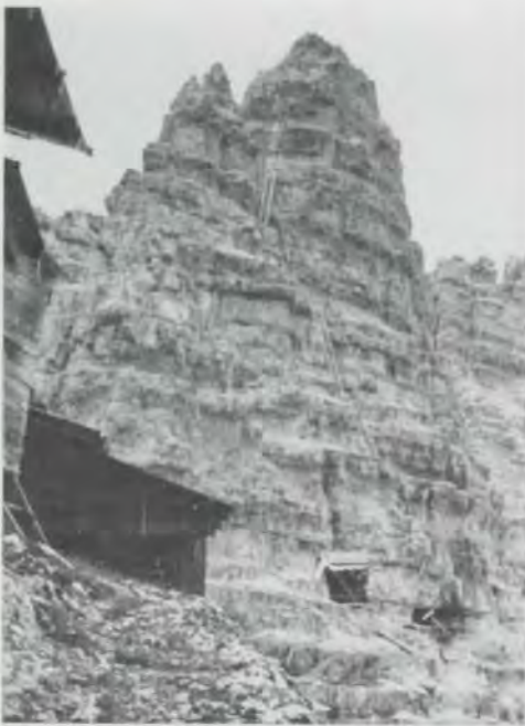
Abb. 239: Stellungen und Leitersteige am Westgrat des Paternkofels. An der Alpenfront wurden vielerorts künstliche Bänder und Gesimse in die Felsen gesprengt und Steige durch senkrechten, oft überhängenden Fels geführt. Für die Bestimmung des günstigsten Weges wurden alpine Referenten, die oft Mitglieder des DuOeAV waren, herangezogen.
