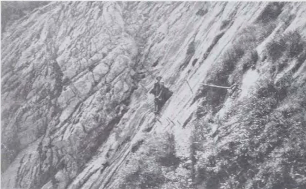
Abb. 90 (links oben): Anfang des 20. Jahrhunderts wurden häufig kühne Klettersteige, die fast ausschließlich aus Eisentritten, Leitern und Drahtseilen bestanden, angelegt. Im Bild der Anstieg zur Zugspitze durch das Höllental. Solche Wege waren nicht selten die Aushängestücke einer Sektion, Promenadenwege, die oft besser ausgebaut waren als Talwege und Almpfade.
