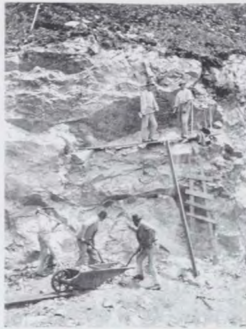
Abb. 41-46: Beim Hüttenbau musste ein Großteil der Arbeit händisch verrichtet werden. Nach Möglichkeit wurden zum Bau Steine und anderes Material aus der Umgebung verwendet. Die Bilder oben zeigen die Aufräumarbeiten nach den Sprengungen für den Bau des Karwendelhauses. In der Mitte sind die Arbeiten an der Krefelder Hütte am Kitzsteinhorn und der Alten Chemnitzer Hütte auf dem Nevesjoch in den Ötztaler Alpen zu sehen. U.li. Dachdeckerarbeiten am fast fertigen Düsseldorfer Hütte oberhalb des Suldentales in der Ortlergruppe, u.re. die entstehende Wangenitzseehütte der Sektion Moravia (Brünn) in der südöstlichen Schobergruppe.
