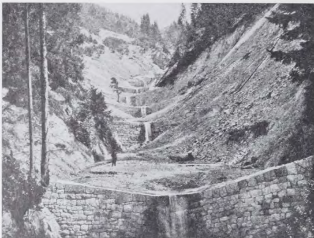
Abb. 185: Wildbachverbauung im Pustertal: Staffe- lung mit Steinsperren im Gödnacherbach.
