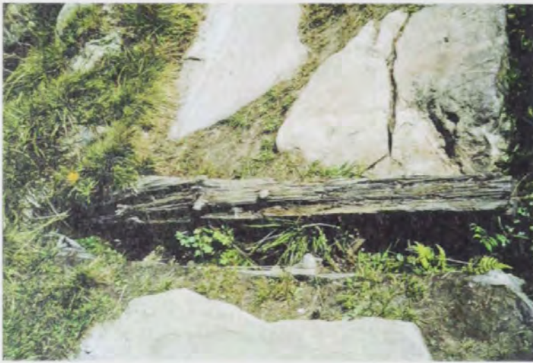
Farbabb. 15: Damit das Wasser gut abrinnen konnte, waren die meisten Alpenvereinswege mit quer über den Weg verlaufenden hölzernen Abflussrinnen versehen. Die Wegoberfläche wurde sorgfältig geebnet und beschottert und wenn möglich mit Steinplatten versehen.
