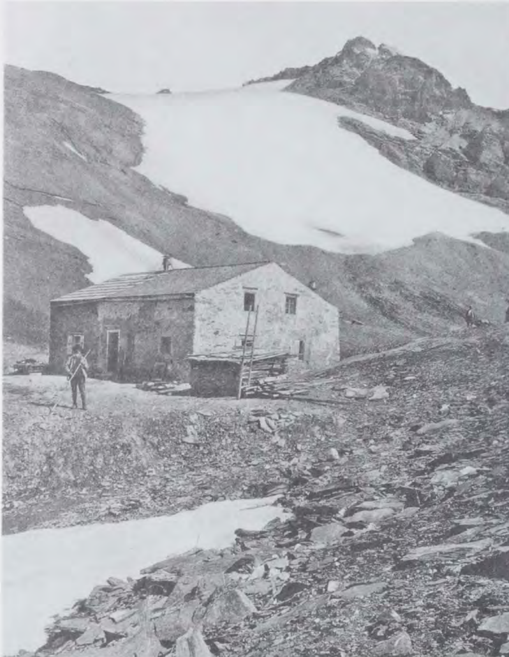
Abb. 22: Der Prager Kaufmann Johann Stüdl ließ 1868 auf eigene Kosten die Stüdlhütte auf der Vanitscharte am Großglockner (hier während Dachdeckerarbeiten) errichten. Die Arbeiten führten hauptsächlich Bergführer aus Kals durch. Die auf 2.803 m Seehöhe gelegene Hütte wurde bis zum Ersten Weltkrieg sechs Mal erweitert.
