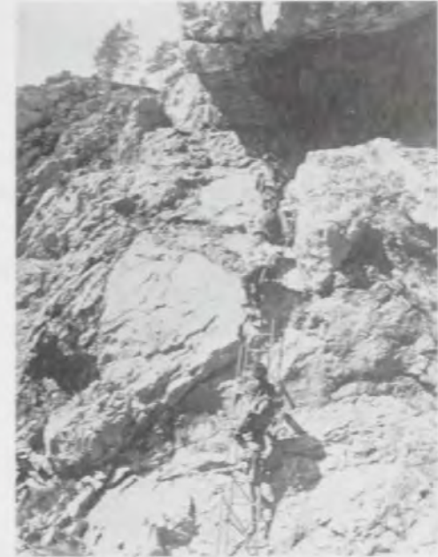
Abb. 89: Der Alpenverein baute immer kühnere Weganlagen. Mit Hilfe von festverankerten Leitern wurden Felsen überwunden. Im Bild der Teufelsbadstubensteig im Raxgebiet.
