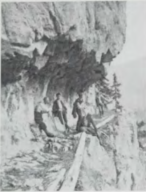
Abb. 98 (links oben): Beispiele des Wegebau des DuOeAV: Der Weg zur 1900 errichteten Hermann-von-Barth Hütte im Lechtal wurde zum Teil mühsam aus dem Felsen herausgesprengt. Beim Wegebau galt es zu beachten, dass ein Weg im Gebirge nach einigen Jahren nicht unwesentlich an Breite verlor, da auf der Bergseite die Böschung herunterrutschte und sich auf der Talseite die Kante abrundete.
