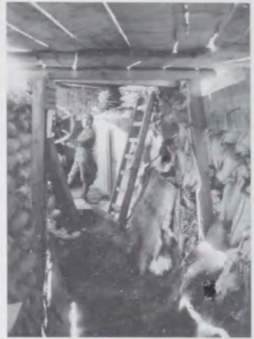
Abb. 243: Ein gedeckter Laufgraben auf der Tuckettspitze. Von hier aus wurde das feindliche Gelände beobachtet und der Feind beschossen. „Manches Bett ist [aus unseren Schutzhütten] hinaus in den Schützengraben gewandert und mancher Fensterstock in die luftige Gipfelbaracke des himmelnahen Postenstandes,“ meinten die Vereinsschriften über die Materialbeschaffung an der Alpenfront.
