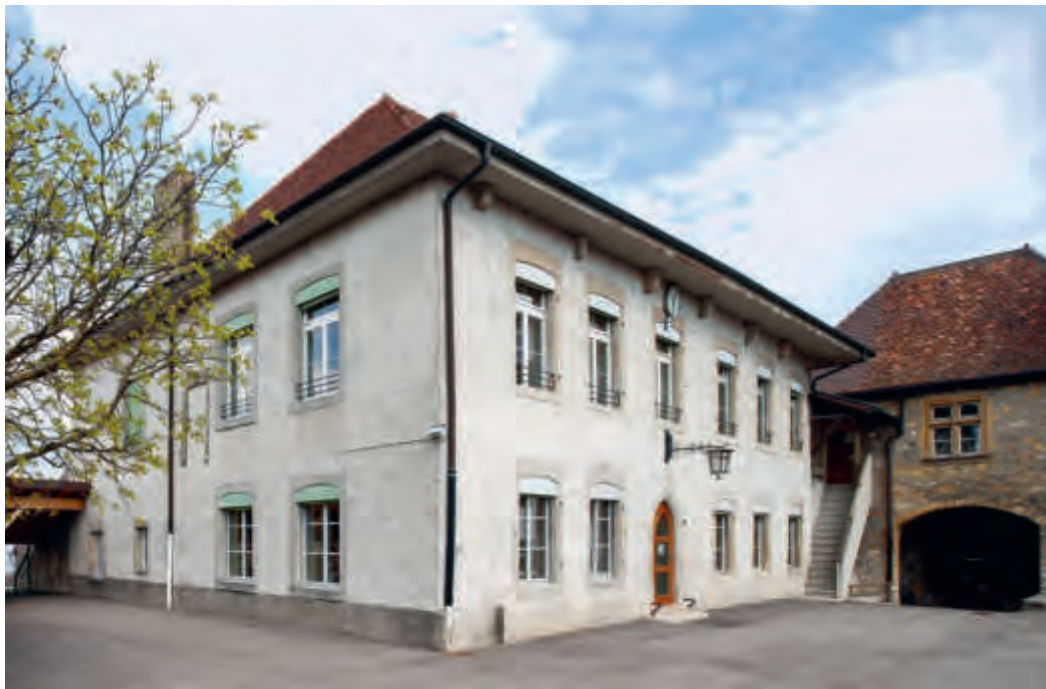
FIG. 147 Impasse de Motte-Châtel 11. Ancienne maison des seigneurs de Rueyres, corps de logis principal. Vue du sud. Baies des années 1850 par Joseph Bahouet. Seules la porte d'entrée et les deux petites fenêtres éclairant la cuisine, sur la gauche, sont antérieures. A droite, la porterie surmontée de la chambre du châtelain. Photo Yves Eigenmann, 2013.
