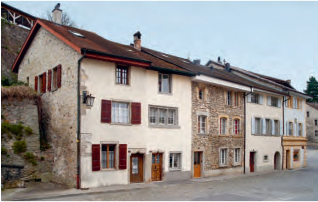
FIG. 573 Ilot de la rue de la Rochette 2-10, au pied des jardins de Motte-Châtel, vu du nord-ouest. Les façades, qui ont généralement conservé leur gros-œuvre médiéval, montrent des ouvertures datant du XV e siècle au début du XX e siècle. Photo Yves Eigenmann, 2014.
