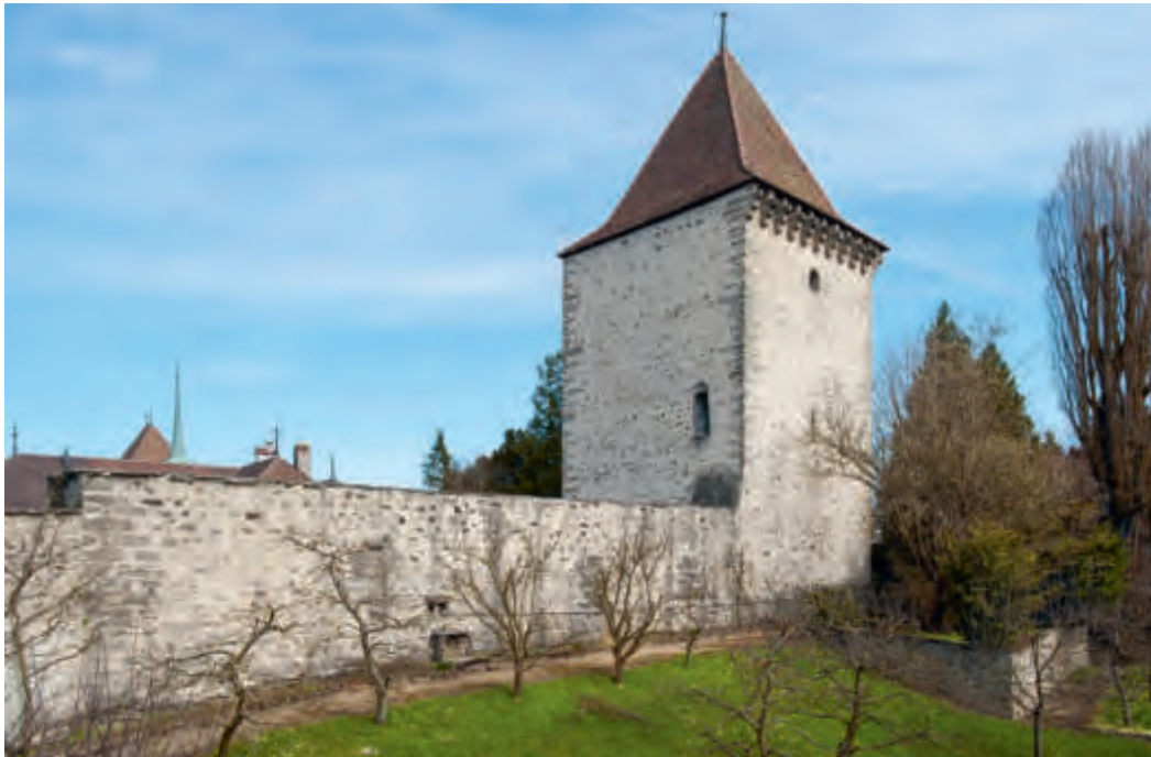
FIG. 452 Château de Savoie. Grande tour et restes de la courtine sud. La porte haute d'accès à la tour était originellement protégée par le parapet du chemin de ronde de la courtine, alors plus élevée. Photo Yves Eigenmann, 2013.
