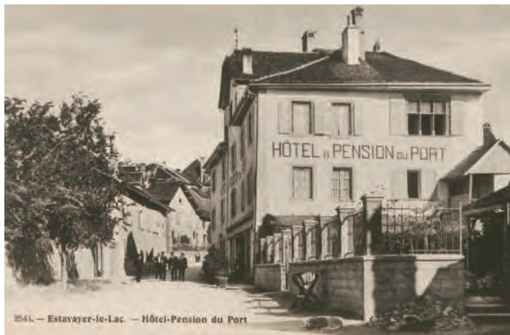
FIG. 605 Rue du Port 3. Façade occidentale des deux anciennes maisons mitoyennes devenues l'Hôtel du Port, après 1920. La maison septentrionale, à gauche, avec ses fenêtres rectangulaires et sa lucarne sur la route du Port, résulte d'un remaniement des années 1810. La maison méridionale, à droite, montre des fenêtres en triplets des années 1550. La porte à linteau sur coussinet du 1 er étage est accessible par un escalier sous une galerie. Carte postale. Coll. Jean-Pierre Grossrieder.
