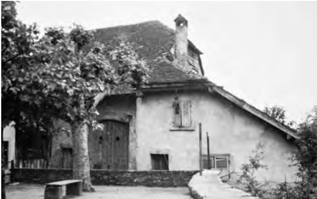
FIG. 433 Place Saint-Claude 13 et 11. Grange et maison vues du nord, avant leur démolition en 1949. Au premier plan, le terre-plein résulte d'un nivellement de 1831 contenu par le mur visible derrière le platane. Le niveau primitif de la place est suggéré par la porte d'entrée de la maison. Photo vers 1940. Coll. privée.
