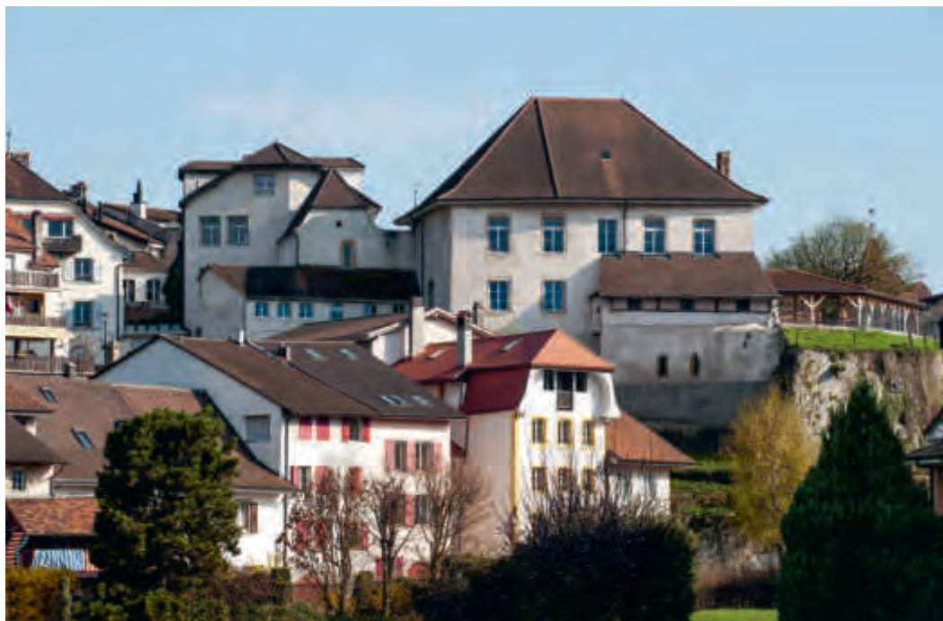
FIG. 146 Impasse de Motte-Châtel 11. Ancienne maison des seigneurs de Rueyres, puis école des garçons. Vue du nord-ouest. De gauche à droite, on distingue le toit à demi-croupe de 1527 couvrant l'ancienne chambre du châtelain au-dessus de la porterie, précédée des commodités scolaires (1920) ; le grand corps de logis unifié au début du XVI e siècle, avec ses baies de 1751 et des années 1850, précédé de l'annexe défensive, dont on voit la bretèche-latrines de 1751. A droite, le jardin de l'esplanade. Photo Yves Eigenmann, 2014.
