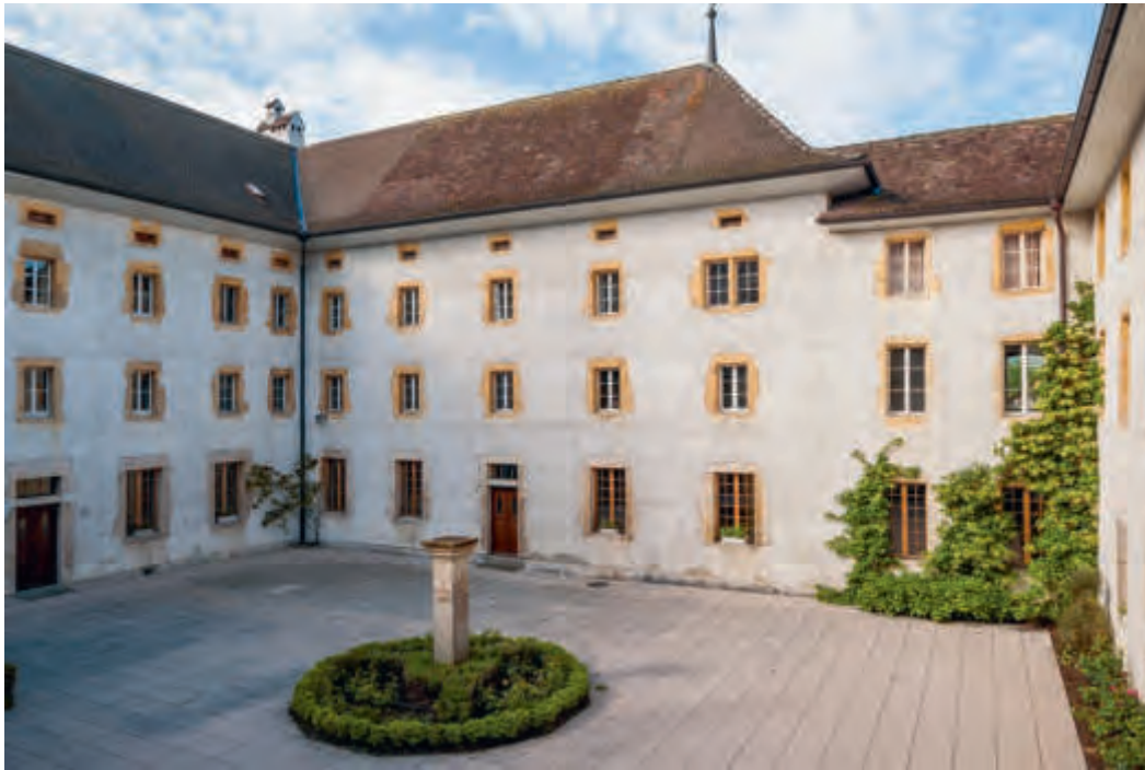
FIG. 476 Monastère des dominicaines. Præu, vue vers le sud. A gauche, les hautes ailes orientale et méridionale de 1687-88. A droite, aile occidentale et jonction avec l'aile sud, de 1735. Photo Yves Eigenmann, 2016.
