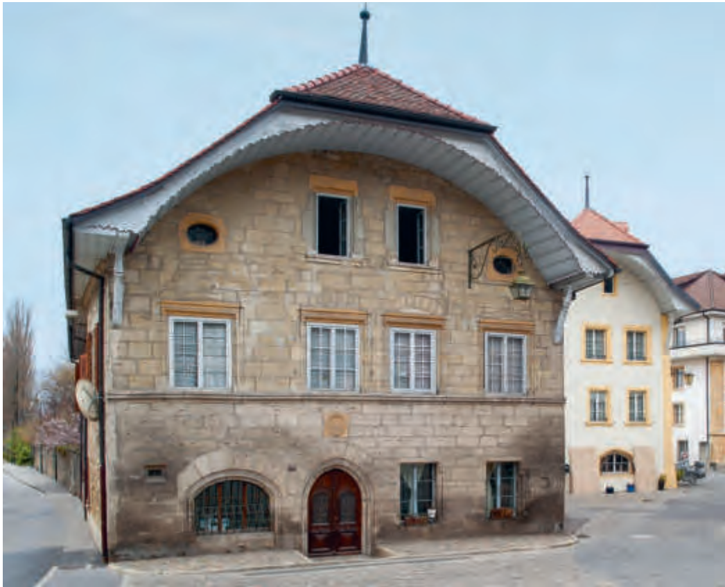
FIG. 580 Grand-Rue 48. Maison Pontherose, façade orientale sur rue. Conception de 1442 avec modifications du début du XVIII e siècle dont l'abaissement de la toiture et la création du berceau lambrissé. Devant la façade, le sol est surélevé lors de l'aménagement de la route du Port en 1890-1892. Photo Yves Eigenmann, 2014.
