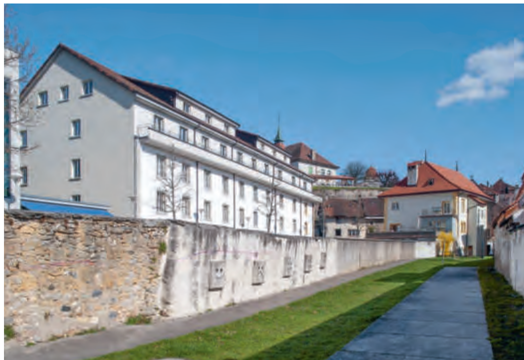
FIG. 559 Faubourg de Petite Rive. Sentier des Lézards, ancienne aire portuaire du « ruz des moulins », soit les « chambrettes » méridionales. Vue en direction de la ville. A droite, des dalles couvrent le ruz des Moulins, canalisé après 1977. Le mur gauche bordait le jardin de la maison Vuillemin, visible à l'arrière-plan. Derrière, l'aile méridionale du pensionnat des jésuites est transformée plusieurs fois pour les besoins de l'Hospice puis de l'Hôpital intercantonal de la Broye. Photo Yves Eigenmann, 2012.
