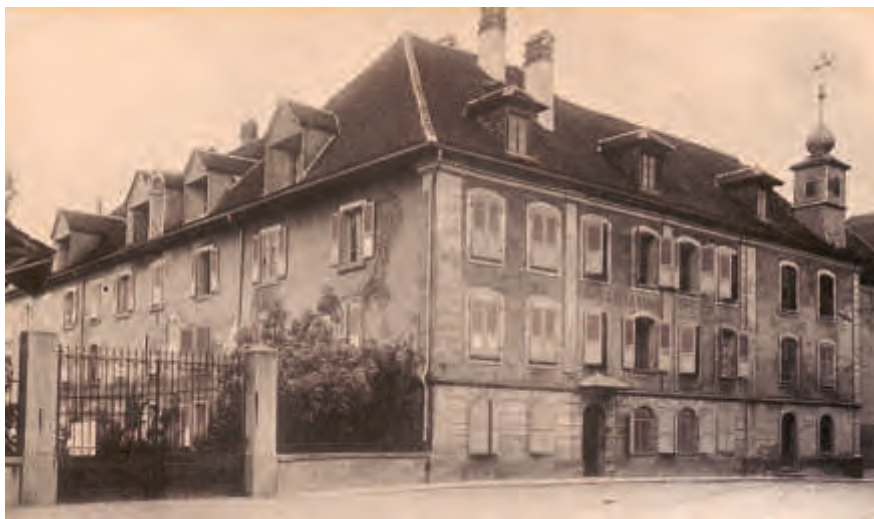
FIG. 565 Place de l'Hôpital 1. Hospice du district de la Broye, vers 1910. Vue du sud. On apprécie le contraste entre la façade sur rue, élaborée, et celle donnant au sud, fort sobre, car masquée par des palissades en bois bordant le port public des Chambrettes. Acquis par l'Hospice en 1901, celui-ci est fermé par le mur et le portail visibles ici. Carte postale. SBC.
