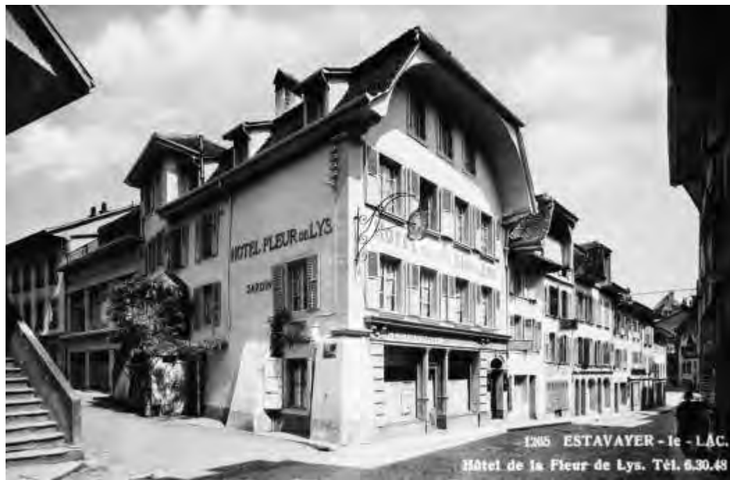
FIG. 361 Rue de la Gare 12. Hôtel de la Fleur de Lys dans les années 1940. Derrière le perron végétalisé, l'arrière-corps sur-élevé à deux axes correspond à l'ancienne écurie et grange à foin disparue avant 1817. A côté de celui-ci, le bâtiment de la grande salle. A gauche, l'escalier donnant accès au 1 er étage de l'ancienne maison Liardet, disparue en 1949. Carte postale coll. Jean-Pierre Grossrieder.
