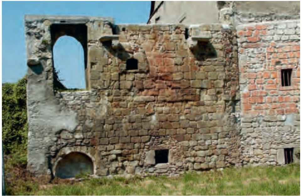
FIG. 156 Impasse de Motte-Châtel 8. Grande maison des coseigneurs d'Estavayer. Paroi intérieure méridionale de la maison 1, antérieure à 1273. Vue du nord. Le remblai a en partie comblé le rez-de-chaussée dont on ne voit ici que la partie haute de la porte. Photo Daniel de Raemy, 2005.
