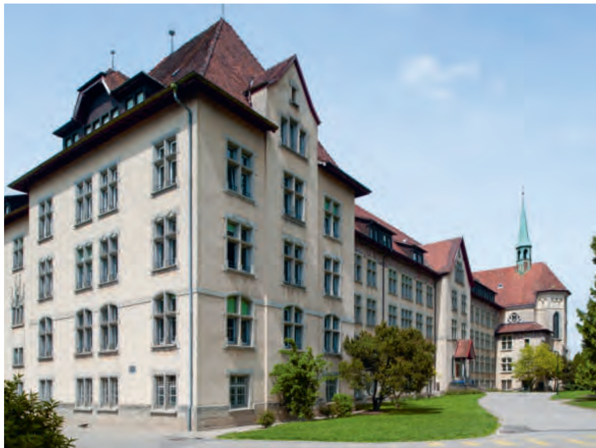
FIG. 73 Chemin du Sacré-Cœur 2. Ecole du Sacré-Cœur. Vue générale du sud de la grande face de l'entrée, côté parc. Photo Yves Eigenmann, 2013.
