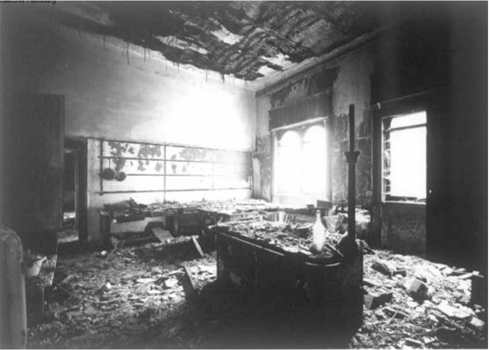
Küche in Gustav Amsincks ehemaliger Villa in Bellagio nach einem Brand in den 1990er Jahren
