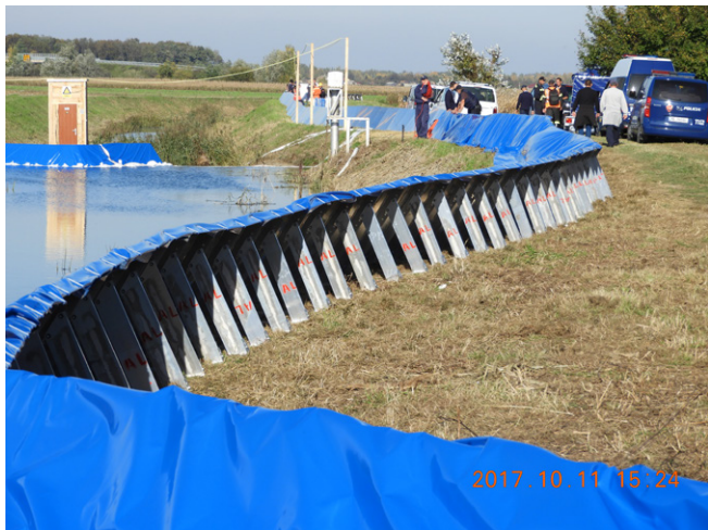
Fig. 5 - Inero Flood Barriers. Foto: © Ingvar Nero.
