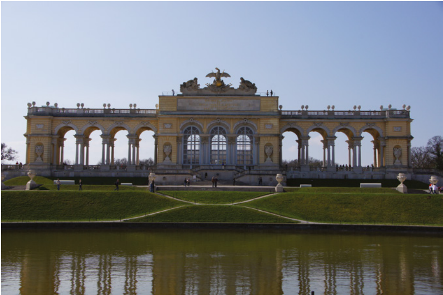
FIGURE 9.31 Johann Ferdinand Hetzendorf von Hohenberg, the Gloriette at Schönbrunn, built 1775 reusing the Neugebäude arcades.
