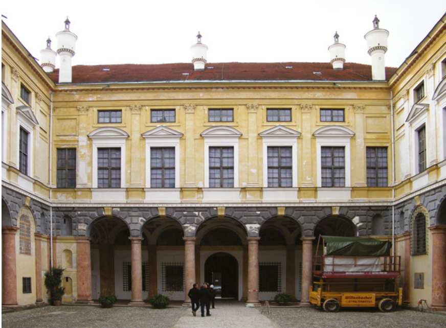
FIGURE 2.1 Landshut, Stadtresidenz, Courtyard facade of the Italienische Bau (1537–1540).
