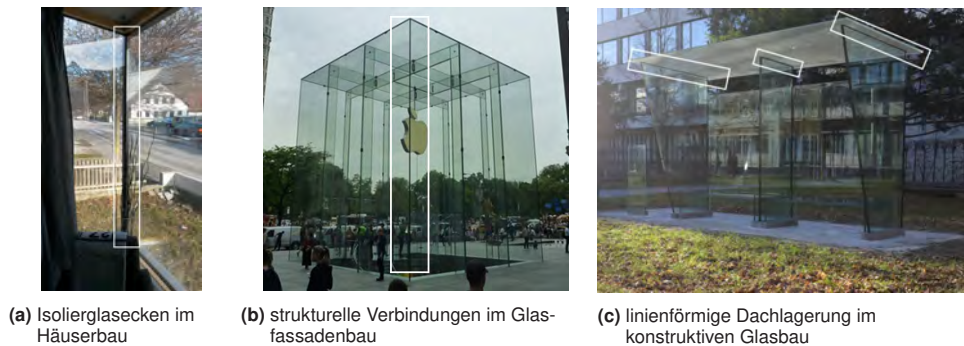
Abbildung 1.2: Anwendungsbeispiele für Klebverbindungen im konstruktiven Glasbau (Quelle: eigene Aufnahmen)
