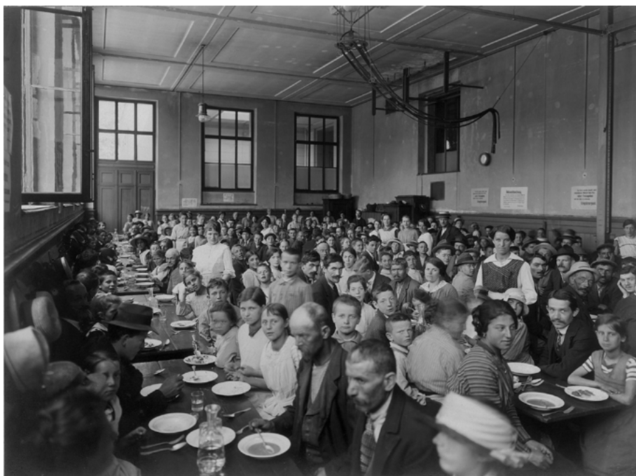
Abb. 19: Knappe Platzverhältnisse und wenig Zeit. Das Schöpfen und Verteilen der Speisen in den Esslokalen war eine logistische und organisatorische Herausforderung. Die zumeist aus der Arbeiterschicht stammenden Familien kamen nach 12 Uhr und mussten um 13 Uhr bereits wieder in den Betrieben sein. Volksküche Drei Rosen (zwischen 1917 und 1921), Foto Carl Kling-Jenny. (StABS, Bild 13, 606)
