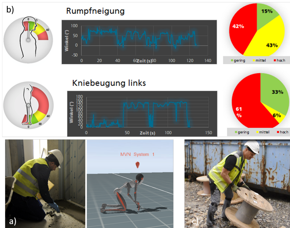
Abbildung 4.2: a) Baustellenmitarbeiter beim Verlegen von Estrich (links), Darstellung des Avatars aus Xsens MVN (rechts). b) In einer aufgezeichneten, beispielhaften Bewegungssequenz von ca. 130 Sek. ist der Rumpf 85 % der Zeit in einer vorgeneigten Haltung. Die Kniegelenke sind in der meisten Zeit mehr als 90° angewinkelt. Darüber hinaus besteht ein hoher Druck auf die Kniegelenke (Darstellung aus Industrial Athlete by scalefit UG). c) Baustellenmitarbeiter beim Umsetzen einer Kabeltrommel. Im Beispiel ist kein Kabel mehr aufgerollt
