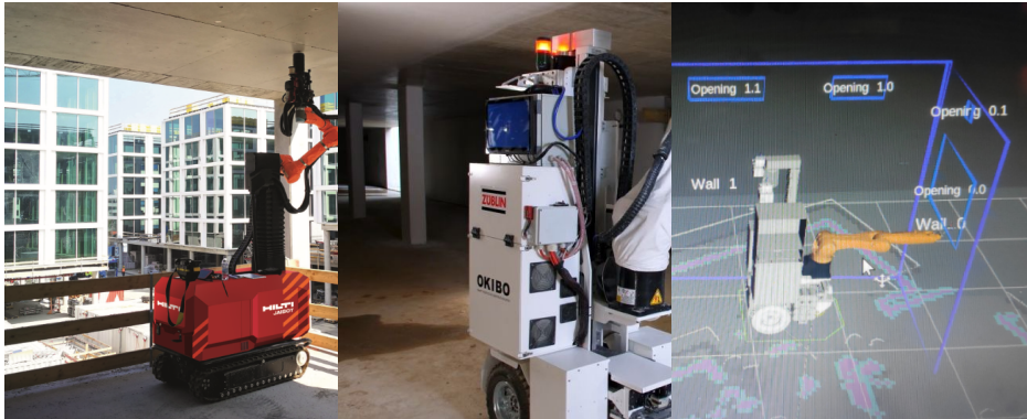
Abbildung 4.4: Einsatz des Bohrroboters Jaibot, BVH „Office V“, Stuttgart-Vaihingen (links) und des Malerroboters von Okibo, BVH „EWB Alleenstraße“, Esslingen (Mitte); Produktionsdaten des Malerroboters Okibo (rechts): Fotos: Ed. Züblin AG
