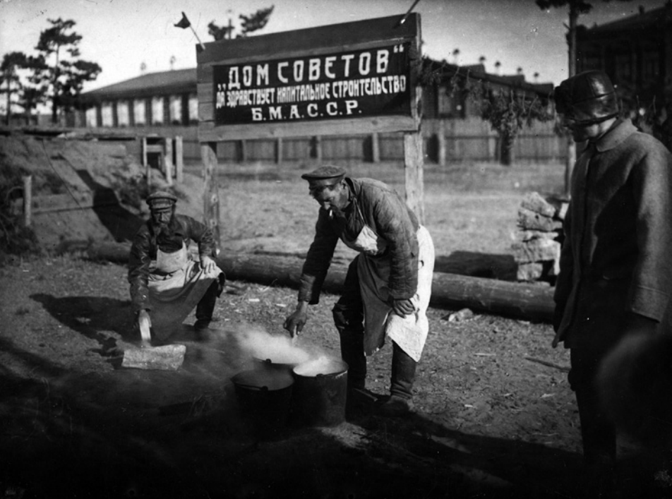
Рабочие строят административное здание в Железнодорожном микрорайоне Улан-Удэ в 1950-е годы
