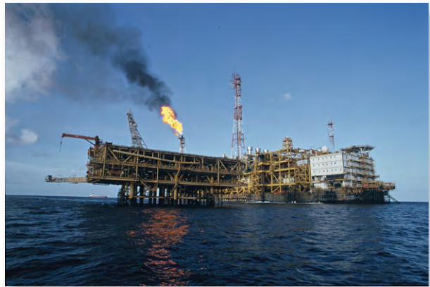
■ Plate-forme de forage et de production sur le site de N'Kossa, au large du Congo, 2002.
