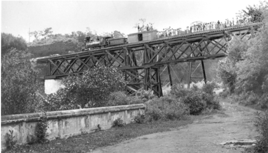
Abb. 7: Die Verapaz-Eisenbahn bei der Überquerung einer Brücke, Cobán, Alta Verapaz, ca. 1930 (Colección Alemana, Fototeca CIRMA, Guatemala)
