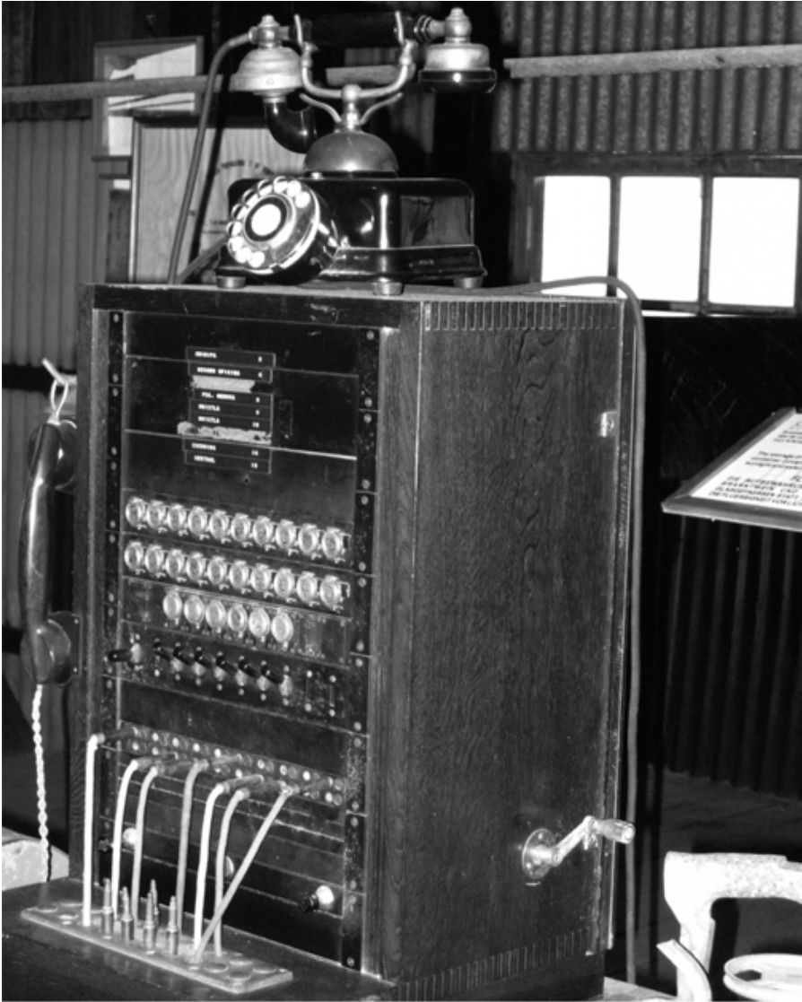
Abb. 50: Die alte Telefonanlage auf der Finca Hamburgo (Foto: privat)
