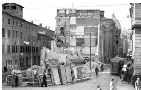
Abb. 109 Beginn der Abbrucharbeiten an der Spina zur Anlage der Via della Conciliazione , im Hintergrund der Petersdom, Jänner 1937
