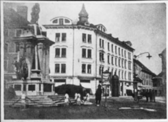
Gegenbeispiel: Illgliche Dach- und Schließung, hässliche und unzuverlässige Fensterverteilung.
