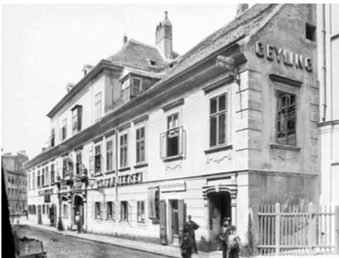
Abb. 62 August Stauda, Ansicht des „Geylinghauses“, Windmühlgasse 28, 1899
