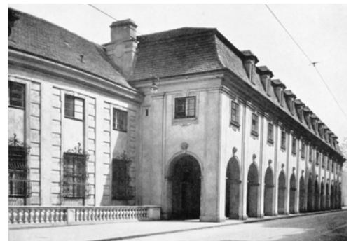
Abb. 60 Carl Wilhelm Schmidt, Nebentrakt des Palais Schwarzenberg an der Prinz-Eugen-Straße nach Anlage der Arkaden, 1927–1929
