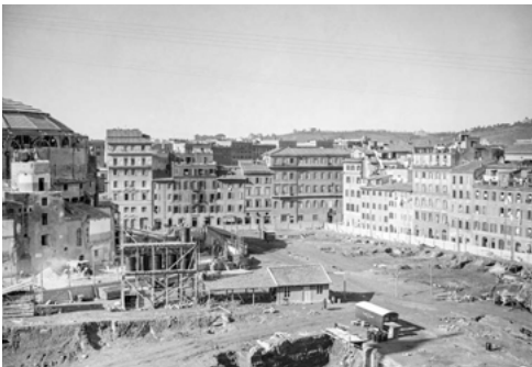
Abb. 106 Piazza Augusto Imperatore, während der Abbruch- und Freilegungsarbeiten, Jänner 1937
