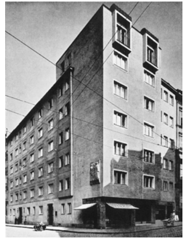
Abb. 18 Hermann Stiegholzer, Assanierungsbau Ecke Beatrixgasse und Ungargasse (Beatrixgasse 5-7), Aufnahme vermutlich 1937
