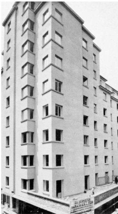
Abb. 93 Angelo Felix Pollak, Assanierungsbau am Laurenzerberg vor der Fertigstellung, Aufnahme vermutlich 1936
