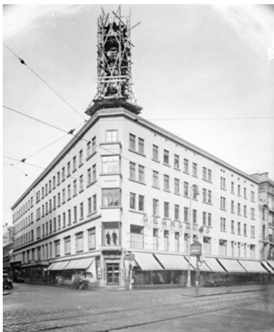
Abb. 53 Kaufhaus Gerngross, Aufnahme über Eck mit Leuchtturm, nach der „Fassadeninstandsetzung“, 1936
