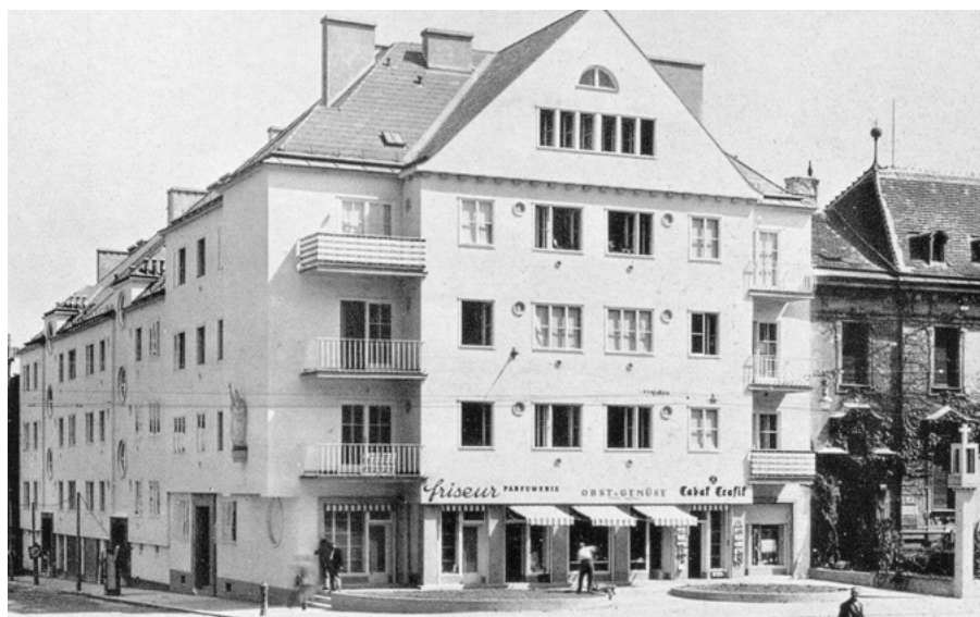
Abb. 36 Karl Krist, Assanierungsbau Billrothstraße 60–62, Aufnahme vermutlich 1937
