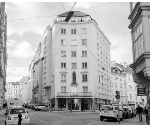
Abb. 15 Assanierungsbau Singerstraße 30–32, Aufnahme Dezember 2017
