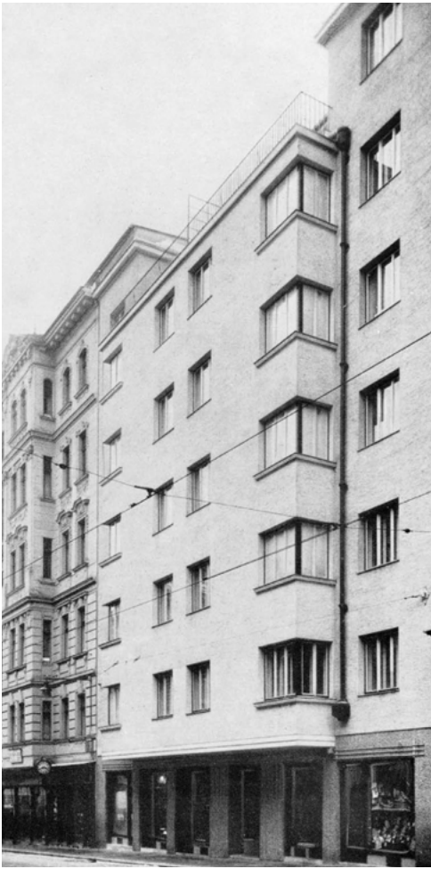
Abb. 42 August Strang, Assanierungsbau mit Staffgeschoss an der Josefstädter Straße 3, Aufnahme vermutlich 1938
