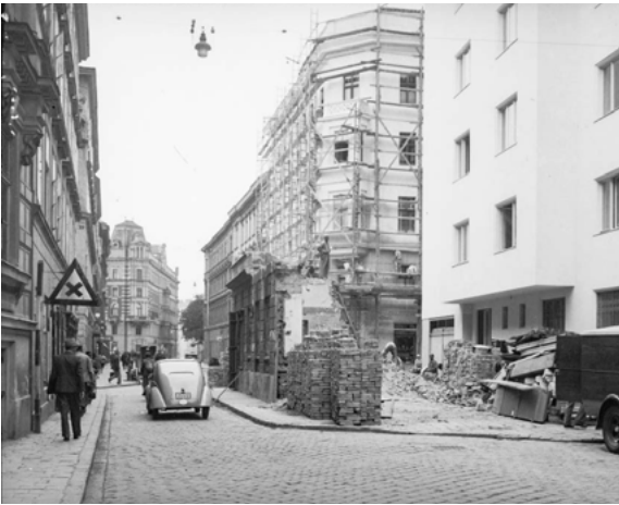
Abb. 95 Assanierungsbau Ecke Reisnerstraße 10 und Beatrixgasse 23; davor sind noch die Reste des dafür abgebrochenen Gebäudes zu sehen, Aufnahme vermutlich 1936
