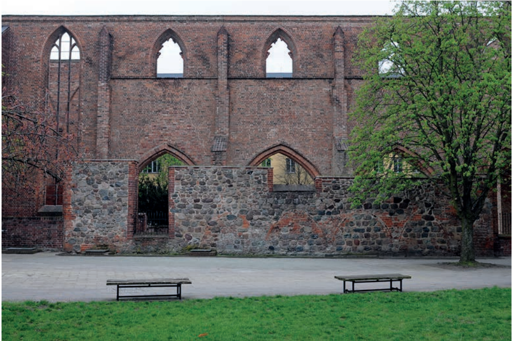
Abb. 1: Nordwand aus Feldsteinmauerwerk.
