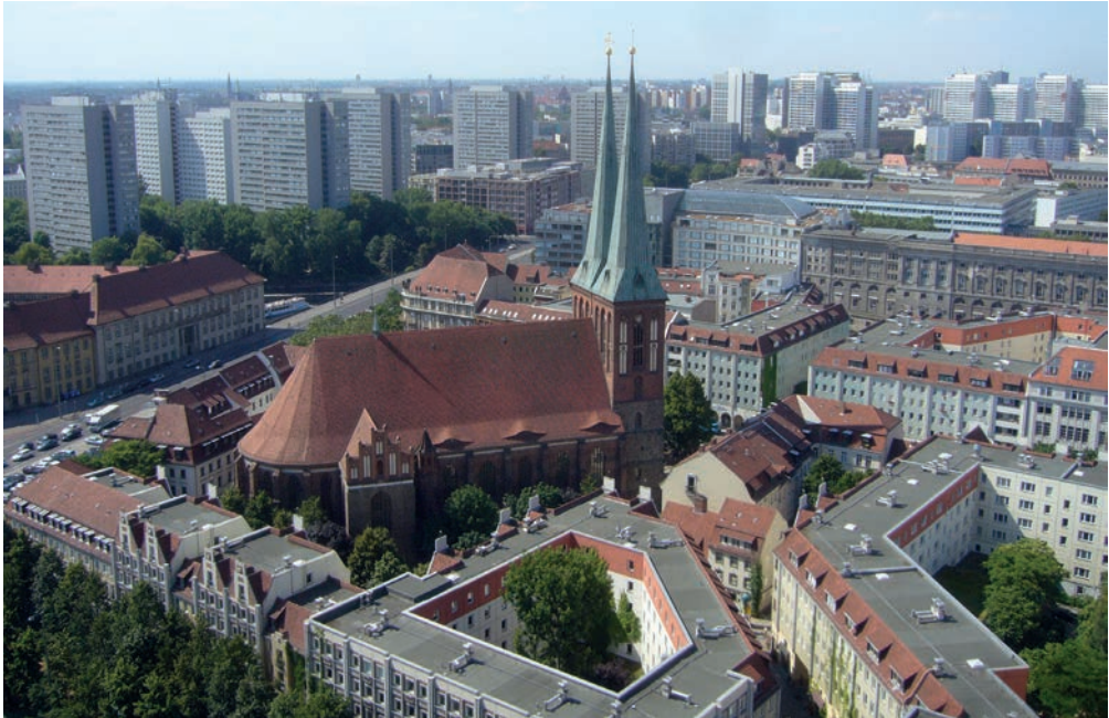
Abb. 6: Berlin, Blick vom Fernsehturm auf das Nikolaiviertel und die Nikolaikirche, Aufnahme 2010.
