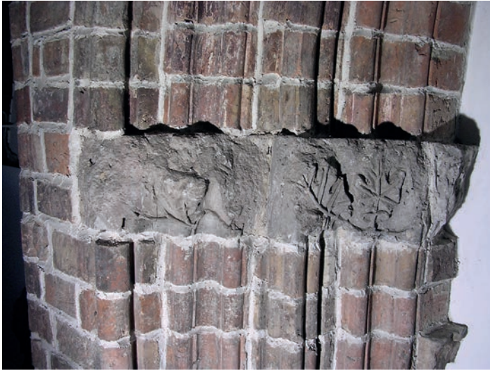
Abb. 4: Berlin, Kämpferdetail des rekonstruierten Portalgewändes des 1931 abgebrochenen Hohen Hauses in der sogenannten Kapelle im Märkischen Museum.
