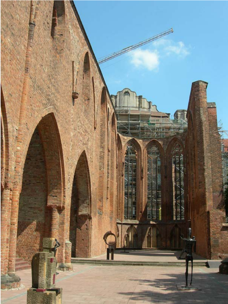
Abb. 12: Berlin, Franziskanerklosterkirche, Ruine von Chor und Langhaus, Blick nach Osten.
