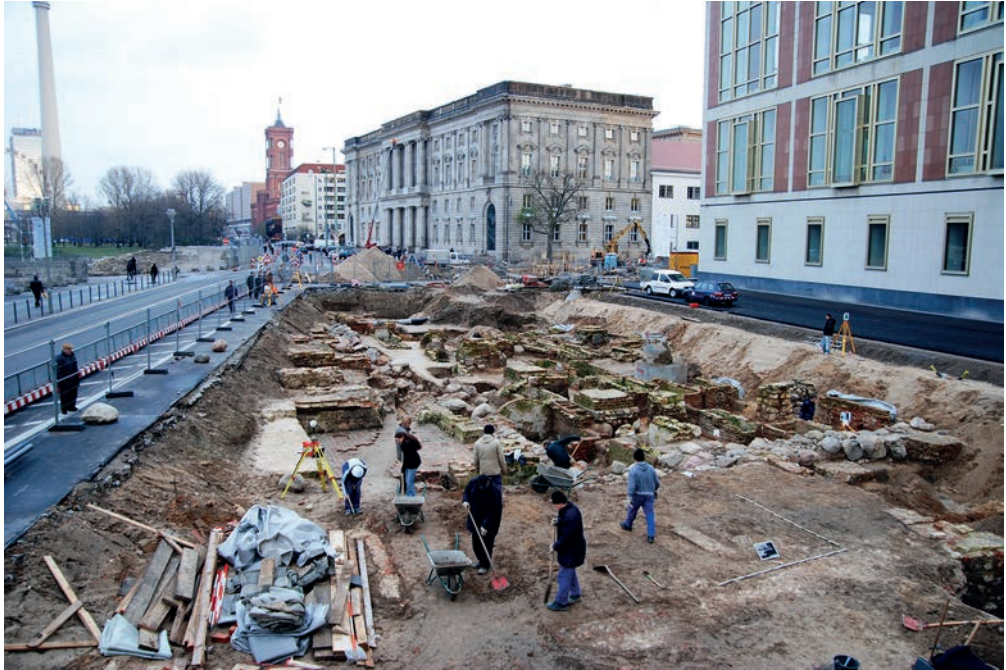
Abb. 3: Freigelegte Fundamente der Dominikanerklosterkirche und späteren Domkirche mit frühneuzeitlichen Grabkammern, Blick gegen Ost im Jahr 2008.
