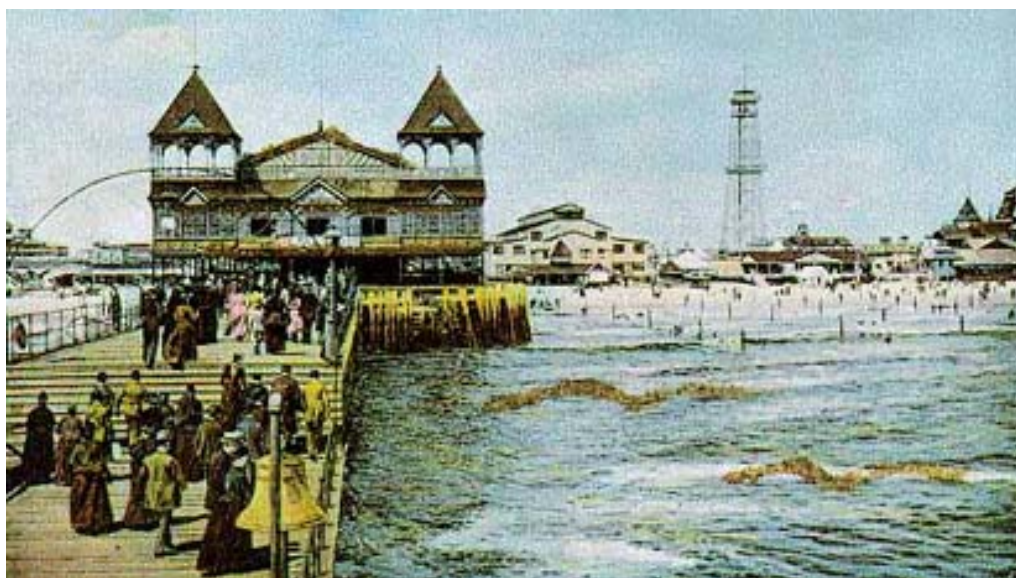
Fig. 3 L’Iron Pier al West Brighton di Coney Island. Sullo sfondo è l’Iron Tower, importato dalla Philadelphia Centennial Exposition del 1876.
