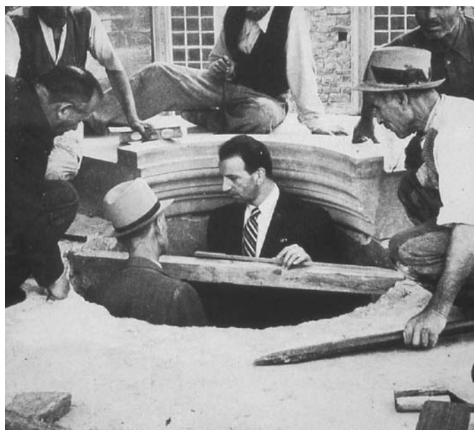
Fig. 3 – Firenze. Basilica di San Lorenzo. Lavori alla lanterna della Sacrestia Vecchia.
