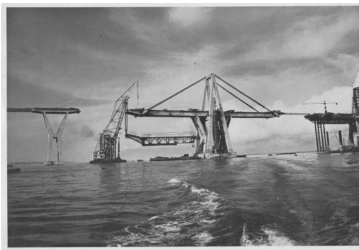
Fig. 2 – R. Morandi, ponte sulla laguna di Maracaibo (1957-62) in Venezuela, in costruzione.
