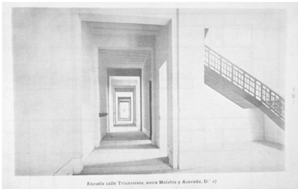
Figure 5: Primary school, interior view: corridor and stairs. Consejo Nacional de Educación (1902). Edificios para escuelas. Su inauguración. Digna conmemoración de los sucesos de mayo de 1810. El Monitor de la Educación Común , Año XXII, T. XVIII, Núm. 351, pp. 7–109 (unknown photographer).
