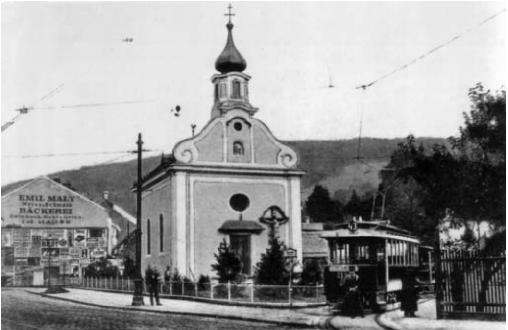
St.-Anna-Kapelle in Neuwaldegg, Fassadenuhr ausgebaut zwecks Elektrifizierung, Foto: P. Ledermann, um 1910
