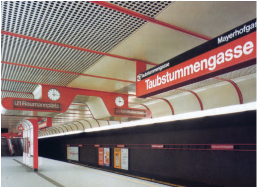
U-Bahn-Station Taubstummengasse, 1980 und 2008
