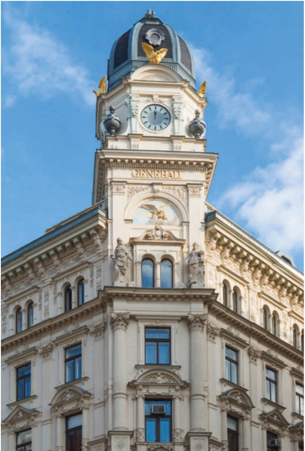
Geschäftshaus, 1. Bezirk, Am Graben 8/Ecke Spiegelgasse
