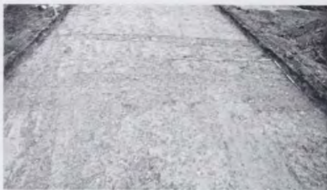
Abb. 18: Straßenschotterung mit nördlich anschließender Mauer M7 (SE 73).
