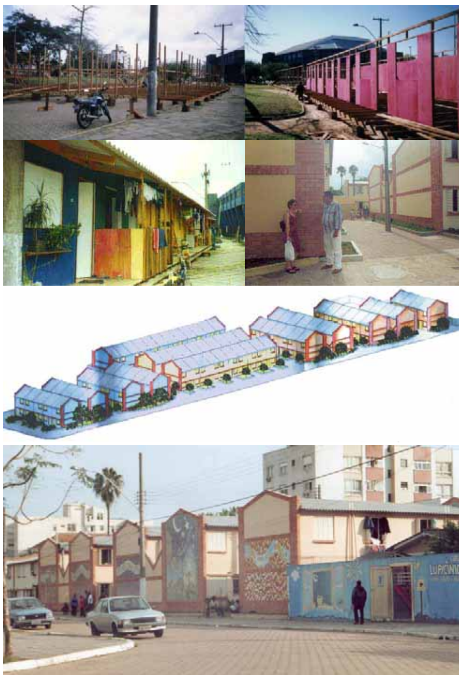
Fig. 95 - I lavori di ricostruzione di Vila Lupicínio Rodriguez sono iniziati alla metà del 1999, con la costruzione delle 'case di passaggio' nella piazza antistante, per alloggiare temporaneamente gli abitanti. Una volta rialloggiati, nel 2000, gli abitanti hanno istoriato le facciate delle stecche di alloggi popolari con dei mosaici rappresentanti la vita del musicista che dà il nome al condominio popolare, e che lo dava anche alla favela che esso ha sostituito.
