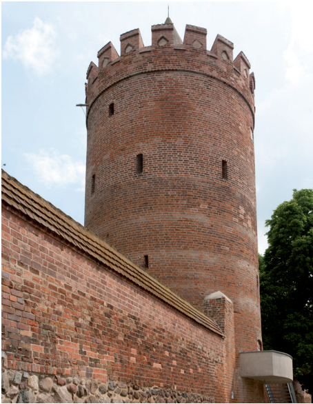
5 Hexenturm im östlichen Abschnitt der Stadtmauer.
