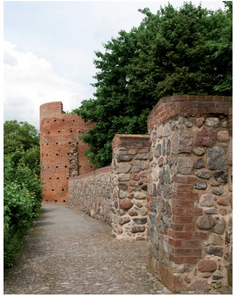
6 Pulverturm im nordöstlichen Abschnitt der Stadtmauer.
