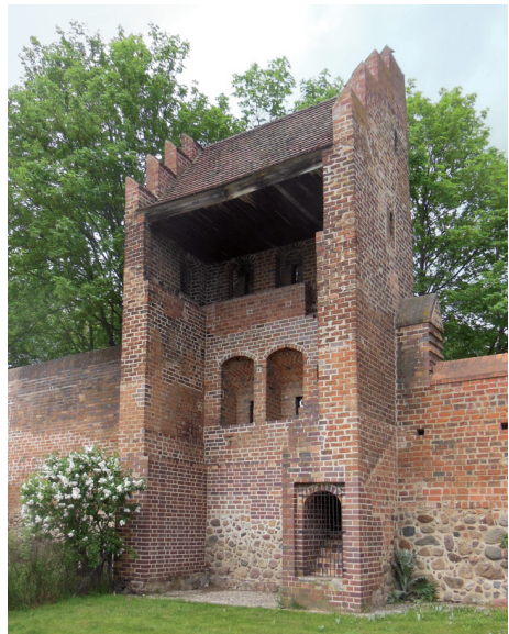
8 Wiekhaus im nördlichen Abschnitt der Stadtmauer.
