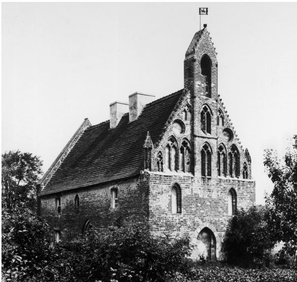
17 St. Georgshospital, Anfang des 20. Jhs.
