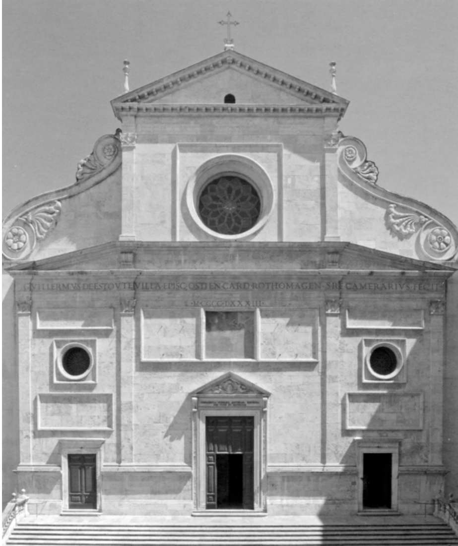
Abb. 6: Rom, Fassade der Kirche S. Agostino.
