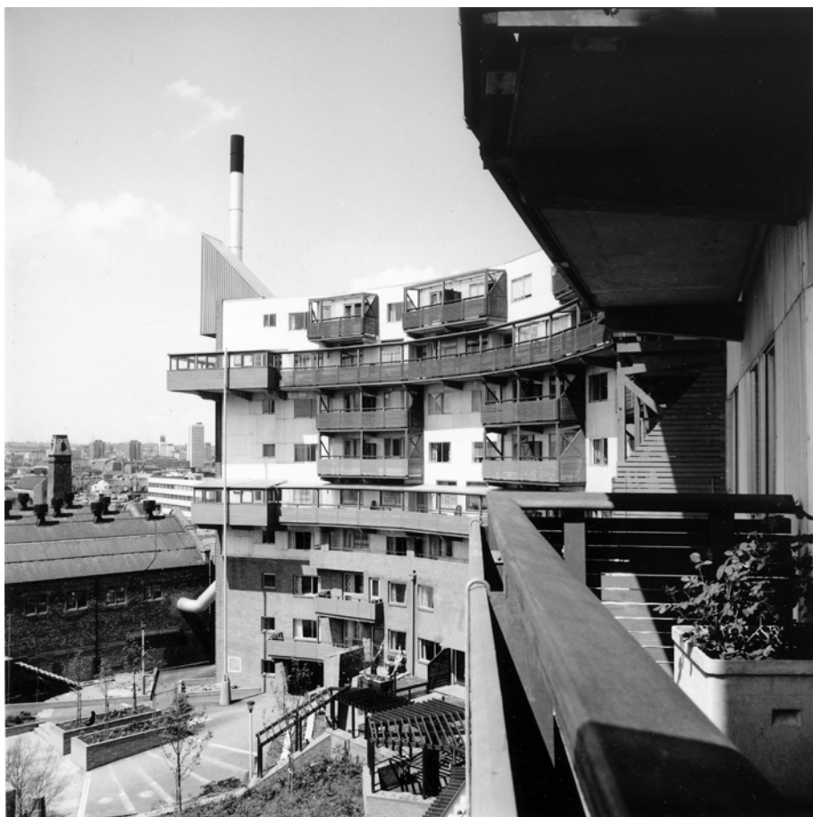
Illustration 14. Les courives d'accès aux logements de Byker Wall , des lieux communs
